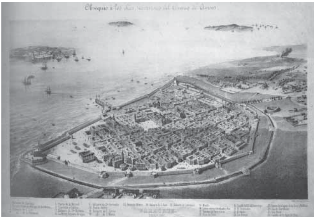
El recinto de Veracruz años antes de su demolición. Vista aérea de Casimiro Castro. © Arquitectura militar de México.
