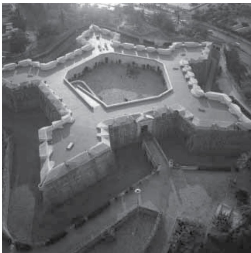
San Diego de Acapulco fue la única obra defensiva realizada en México con traza pentagonal. © Arquitectura militar de México.
