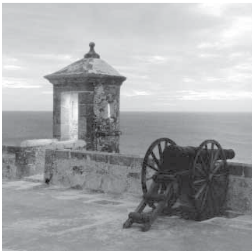
Las obras exteriores tenían como función principal prevenir un posible desembarco extranjero. Reducto de San Miguel, Campeche. © Arquitectura militar de México.
