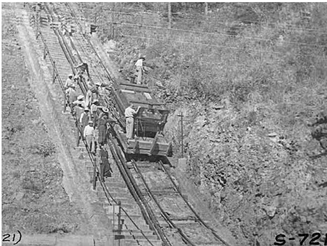
Desplazamiento de un transformador a través del malacate por la pendiente que la mano del hombre pudo dominar en la planta Lerma, estado de Michoacán, 1949. Fototeca de Luz y Fuerza del Centro. Archivo Histórico.
