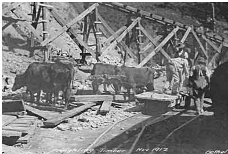
Todos los medios fueron necesarios para poner en marcha varias de las obras en el periodo de influencia de la Mexican Light & Power Company Limited . Fototeca de Luz y Fuerza del Centro. Archivo Histórico.
