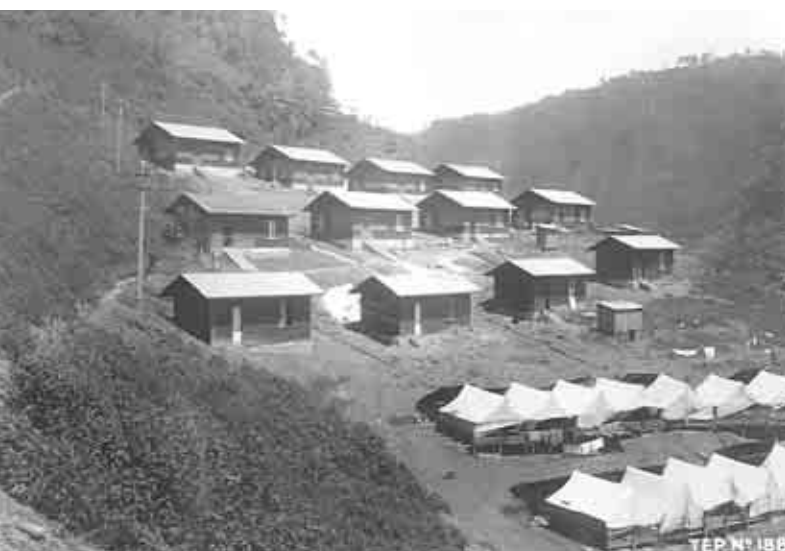
Nos presenta la armonía en que fue instalado el campamento de trabajadores en los alrededores de la planta Tepexic, Puebla, durante el año de 1922. Fototeca de Luz y Fuerza del Centro. Archivo Histórico.
