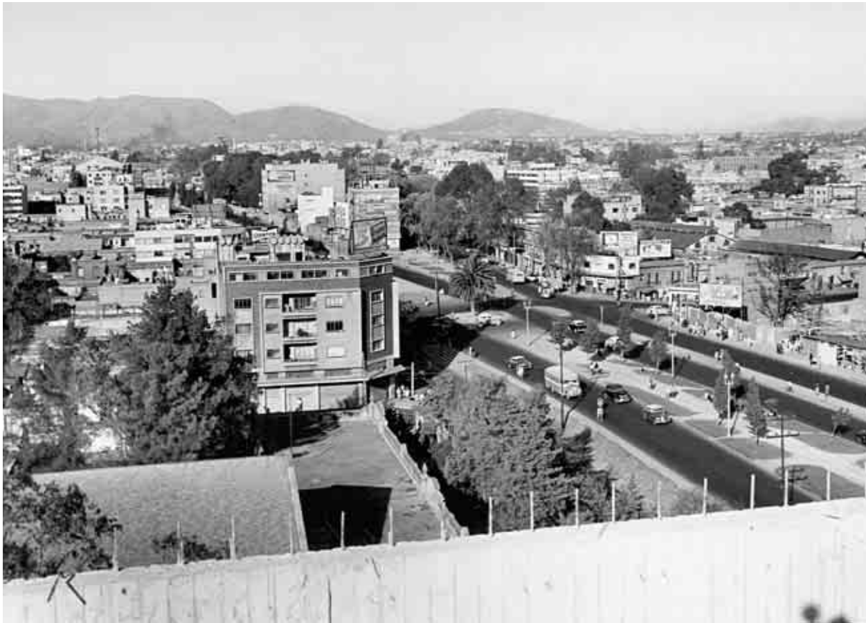
Vista al norte desde lo que eran, en 1950 los avances de la construcción del edificio central de Luz y Fuerza. Colonia Tlaxpana, D.F. Fototeca de Luz y Fuerza del Centro. Archivo Histórico.
