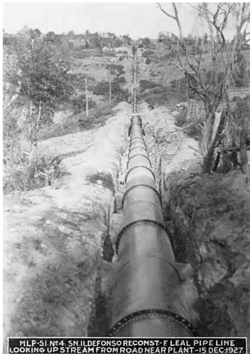
Detalle de la colocación de una tubería a lo largo de una vereda, cercana a la planta "Fernández Leal", Estado de México, 1927. Fototeca de Luz y Fuerza del Centro. Archivo Histórico.
