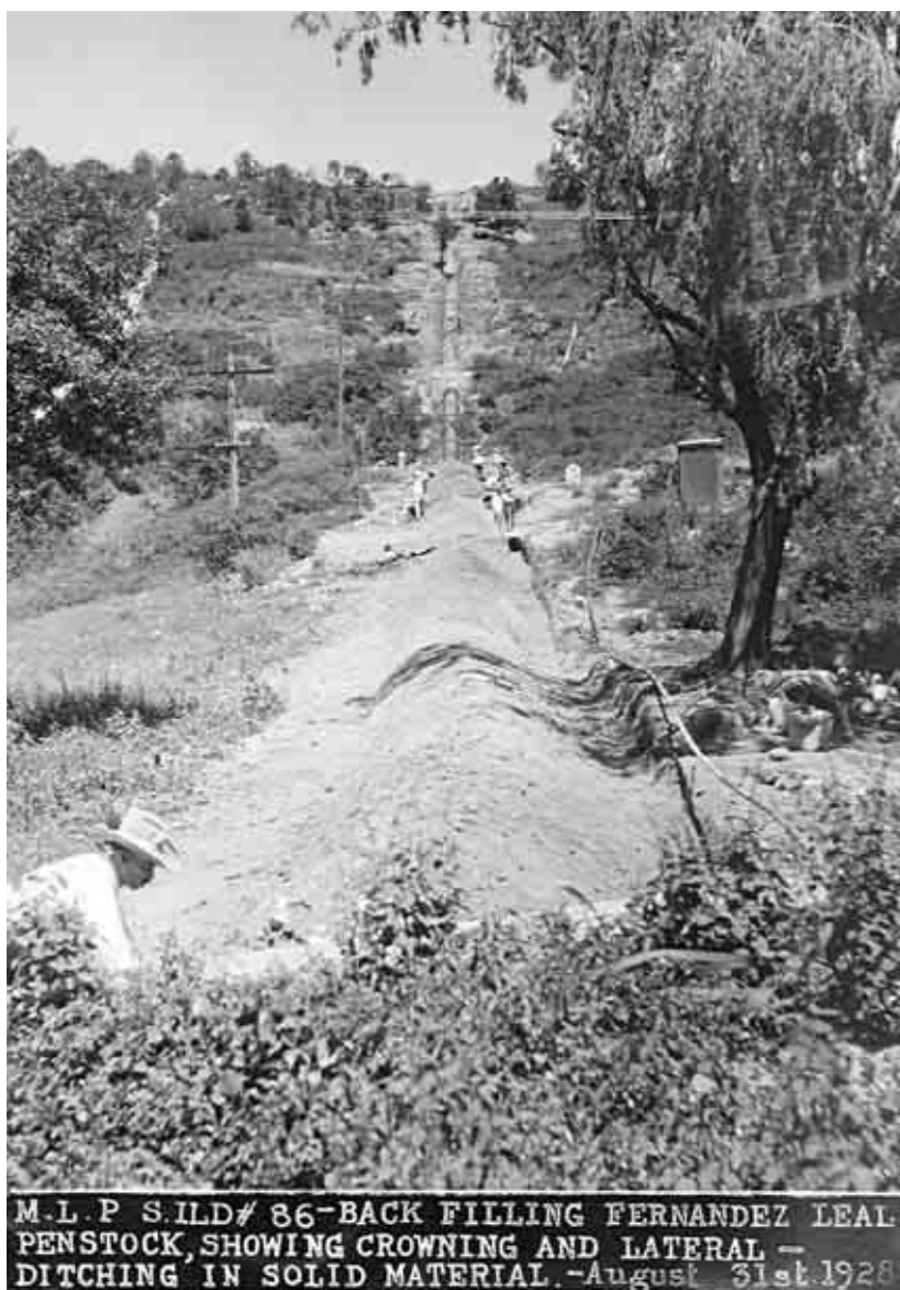
Trabajos en la planta “Fernández Leal”, Estado de México, 1928. Fototeca de Luz y Fuerza del Centro. Archivo Histórico.
