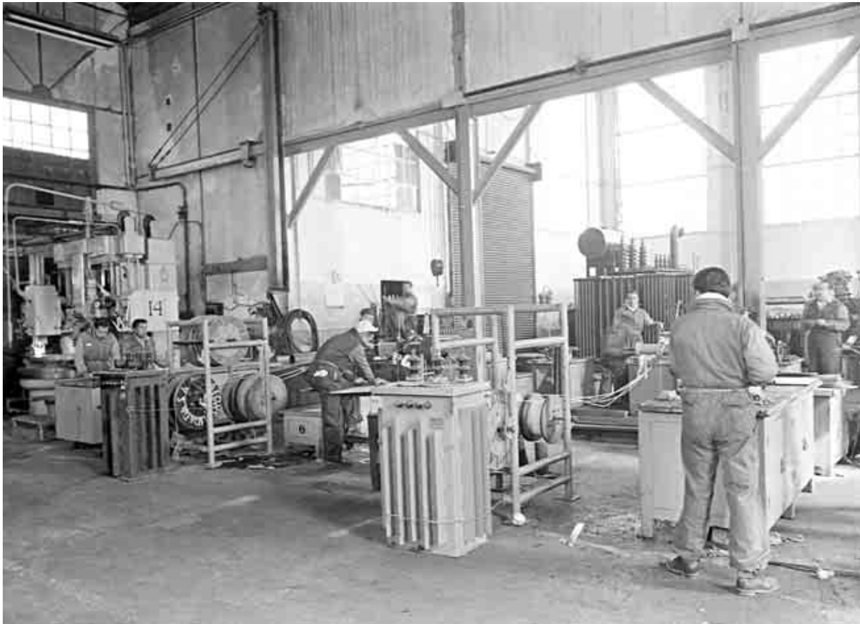
Al interior del Taller de Transformadores Verónica y personal de oficina del mismo centro de trabajo. Ca., 1955. Fototeca de Luz y Fuerza del Centro. Archivo Histórico.
