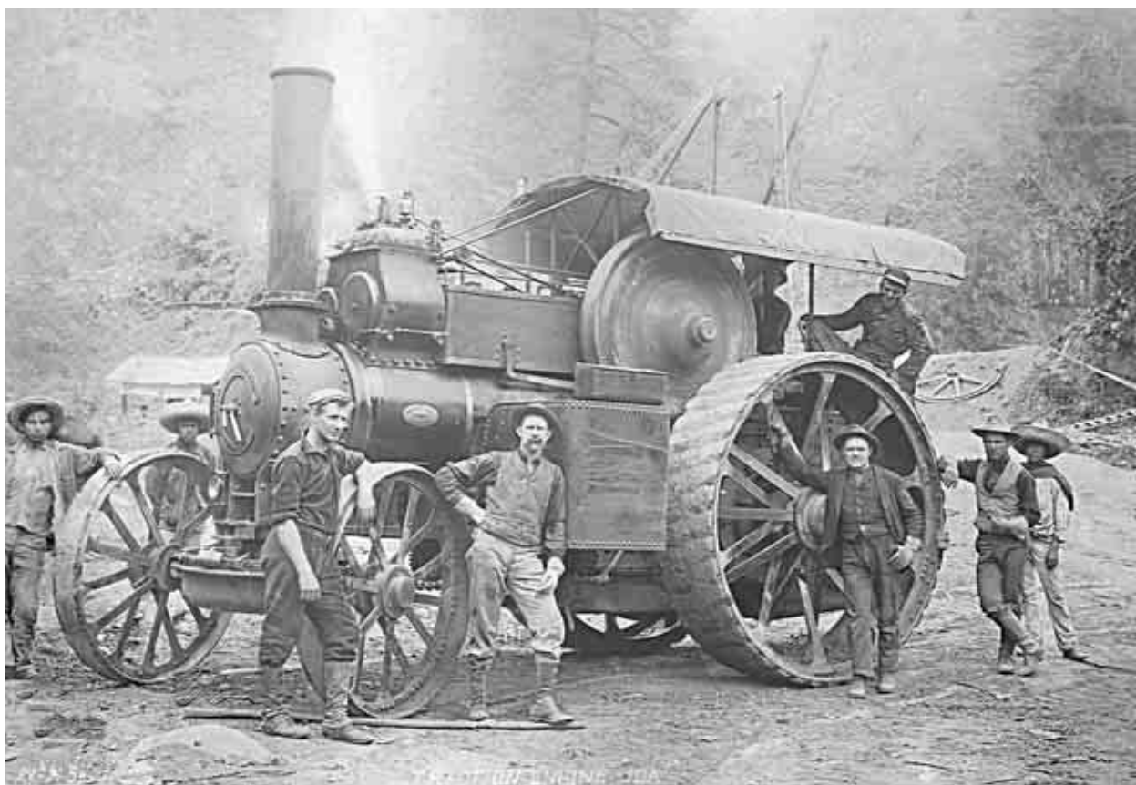
En Necaxa, fueron necesarios todos los medios para construir una obra majestuosa con mano de obra de la región. Este curioso tractor fue una tentativa fallida para enfrentar los lodos de la Sierra Norte. Enero de 1904. Fototeca de Luz y Fuerza del Centro. Archivo Histórico.
