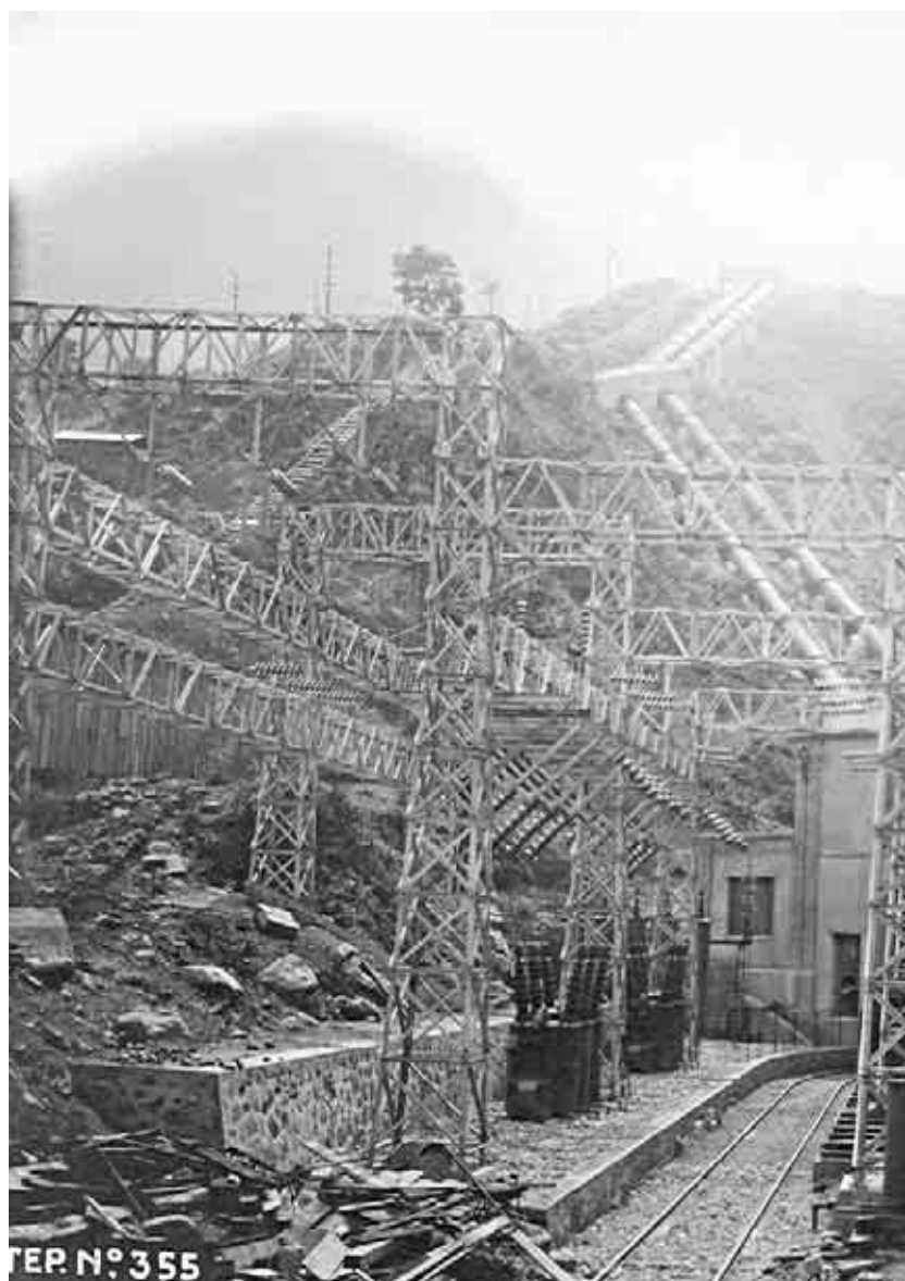
En primer término la subestación. Allá atrás, la casa de fuerza. Todo estaba listo en 1922 para poner
