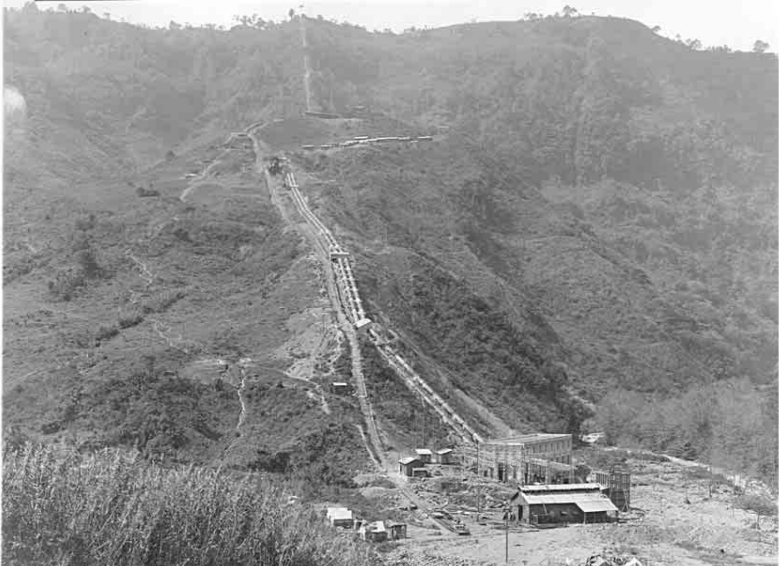
Casa de fuerza y subestación de Tepexic, en primer término, con la vista formidable de la caprichosa naturaleza mexicana como telón de fondo. Fototeca de Luz y Fuerza del Centro. Archivo Histórico.
