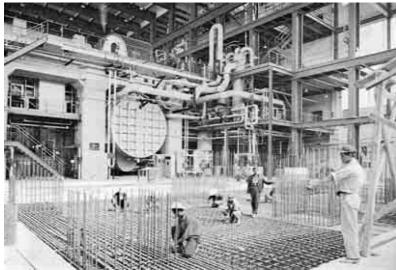
Trabajos de construcción durante el mes de febrero de 1959, para la cuarta unidad en la planta Lechería. Archivo Histórico de Luz y Fuerza del Centro.
