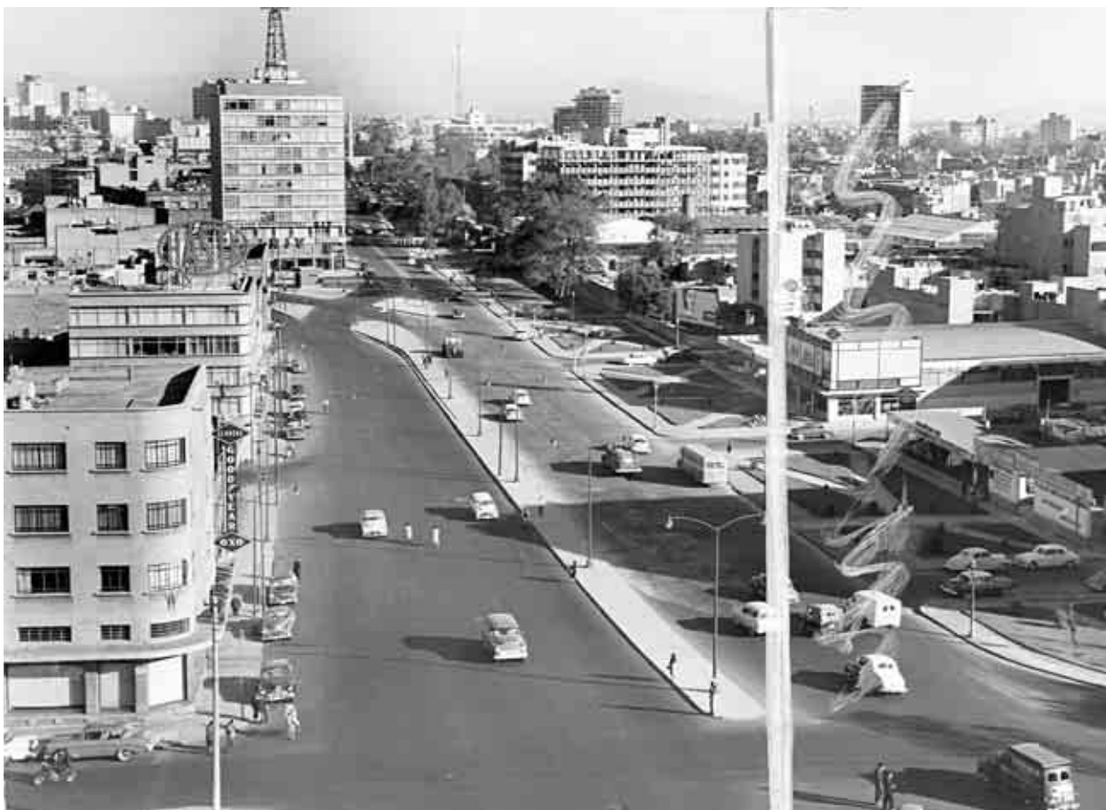
Vista al ponente desde una muy avanzada obra del edificio central de Luz y Fuerza. Colonia Tlaxpana, D.F., 1950. Fototeca de Luz y Fuerza del Centro. Archivo Histórico.
