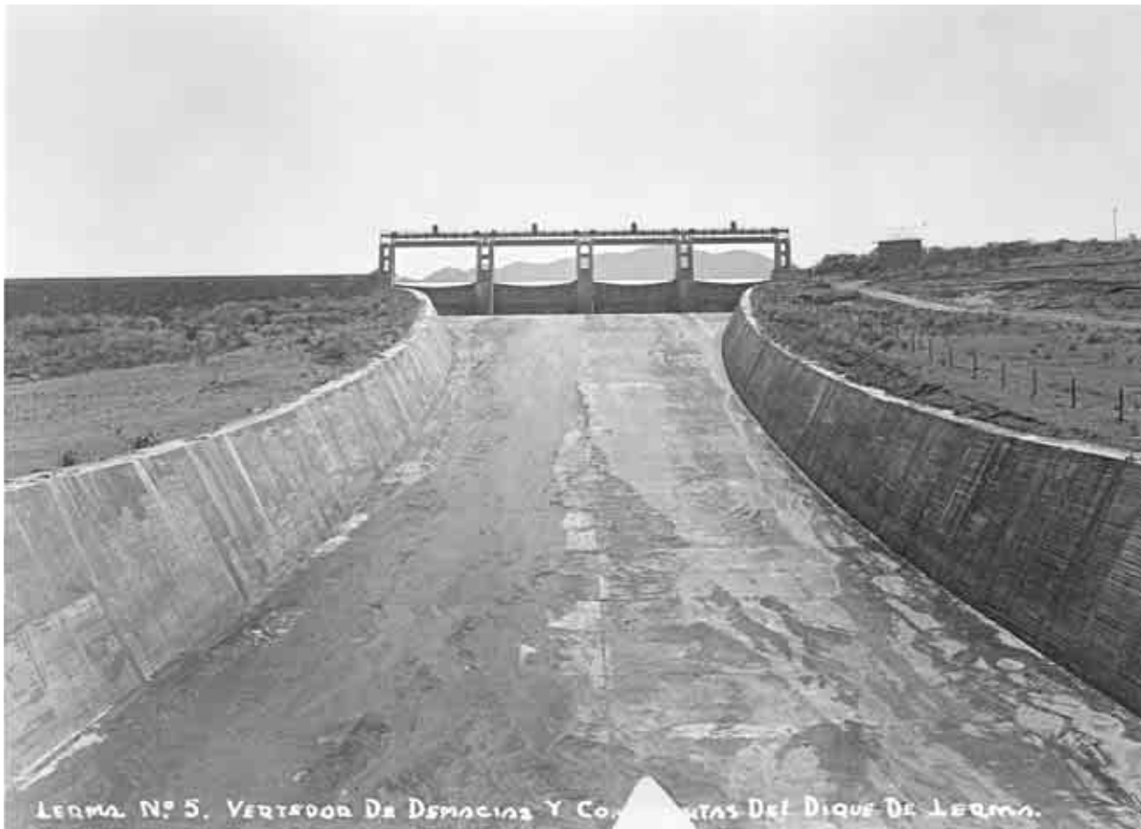
Vertedor de demasías y compuertas del dique de Lerma, estado de Michoacán, 1930. Fototeca de Luz y Fuerza del Centro. Archivo Histórico.
