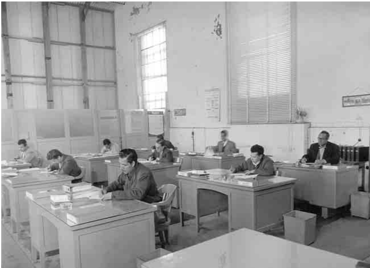
Vistas de los distintos talleres adscritos a la Compañía Mexicana de Luz y Fuerza Motriz, S.A. Ca., 1950. Fototeca de Luz y Fuerza del Centro. Archivo Histórico.
