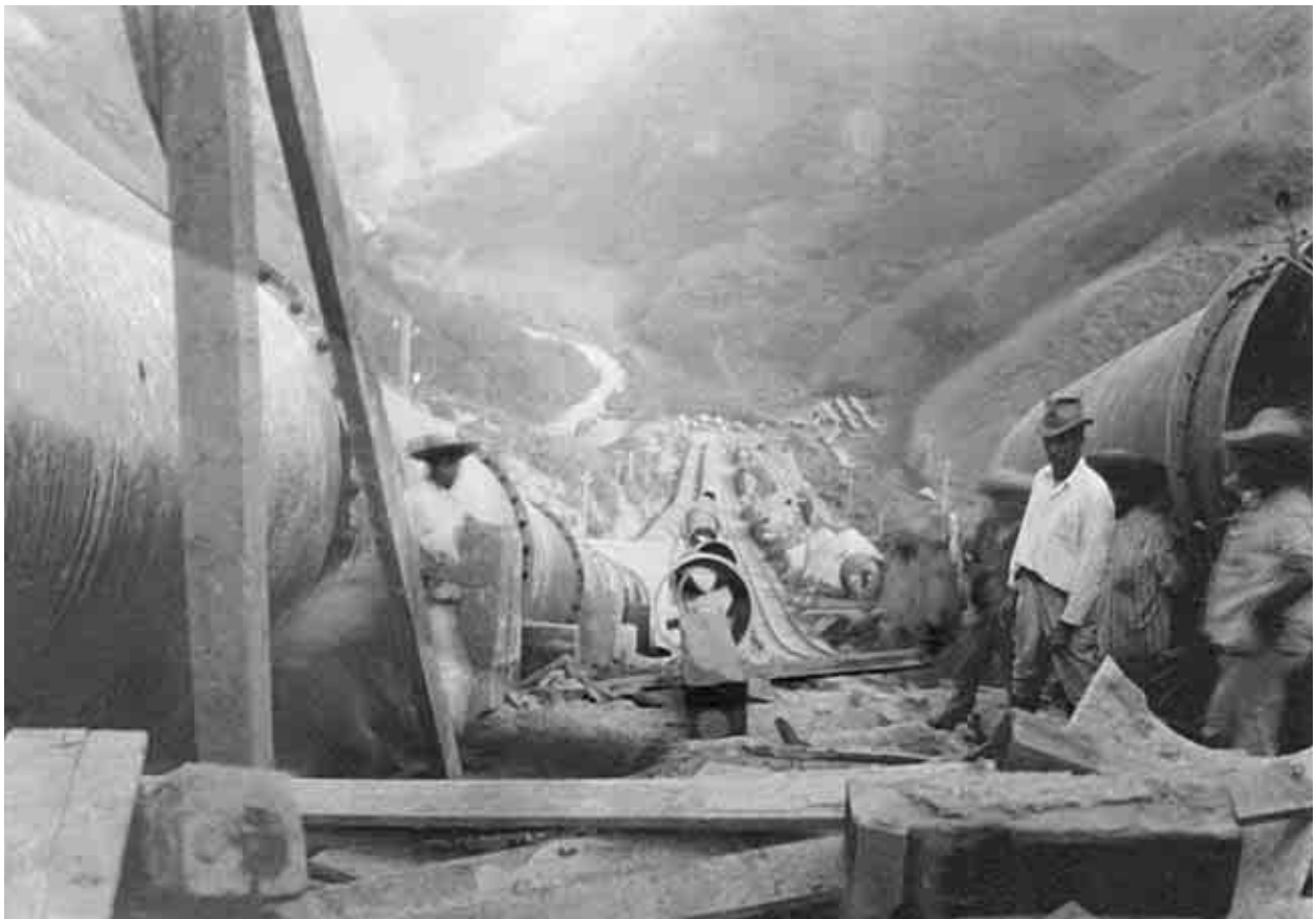
Colocación de la enorme tubería por la cual se alimentaba y se sigue alimentando a la planta hidroeléctrica de Tepexic. Puebla, 1922. Fototeca de Luz y Fuerza del Centro. Archivo Histórico.
