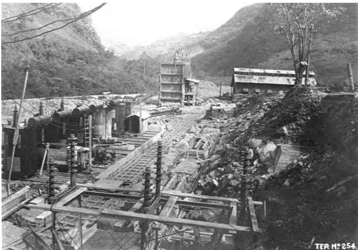
En primer término, parte de la subestación y el banco de transformadores. Planta Tepexic, Puebla. Ca. 1922. Fototeca de Luz y Fuerza del Centro. Archivo Histórico.
