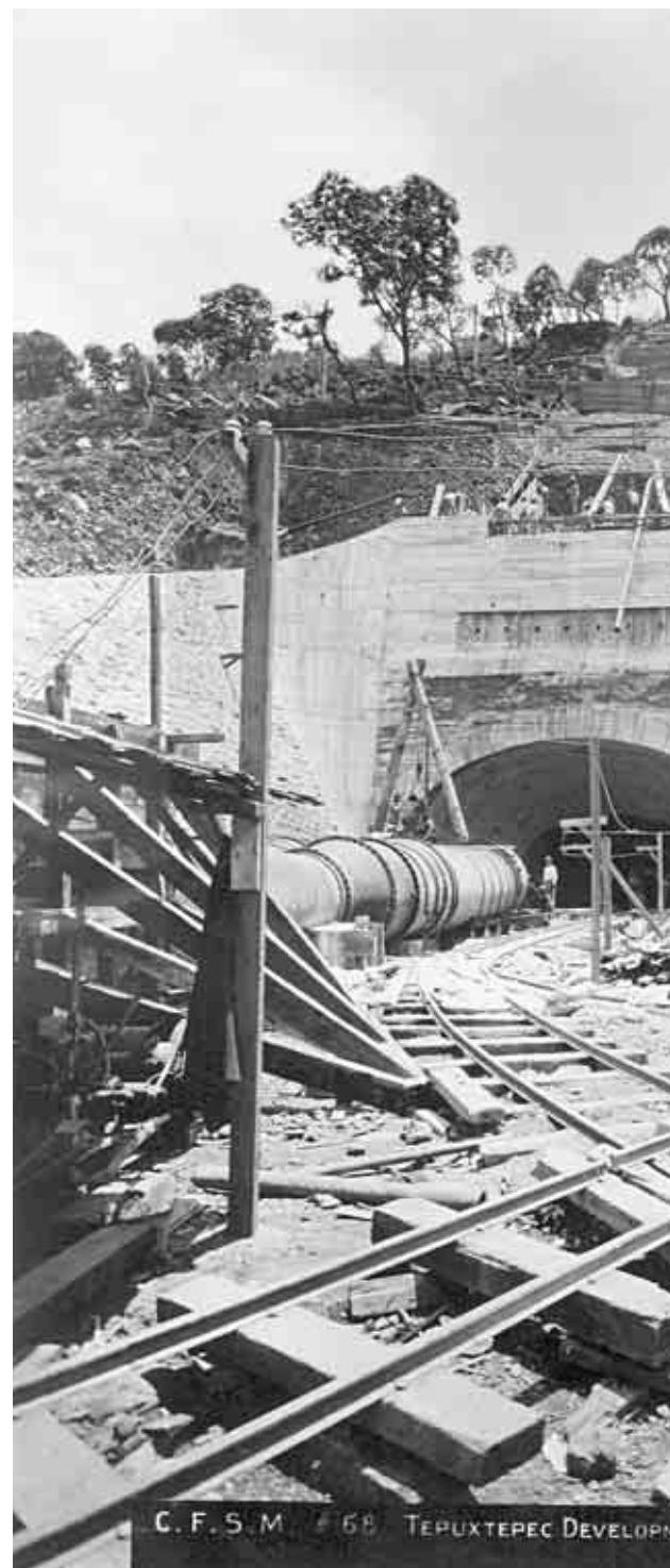
Otro detalle del túnel en Tepuxtepec, estado de Michoacán. 1930.
