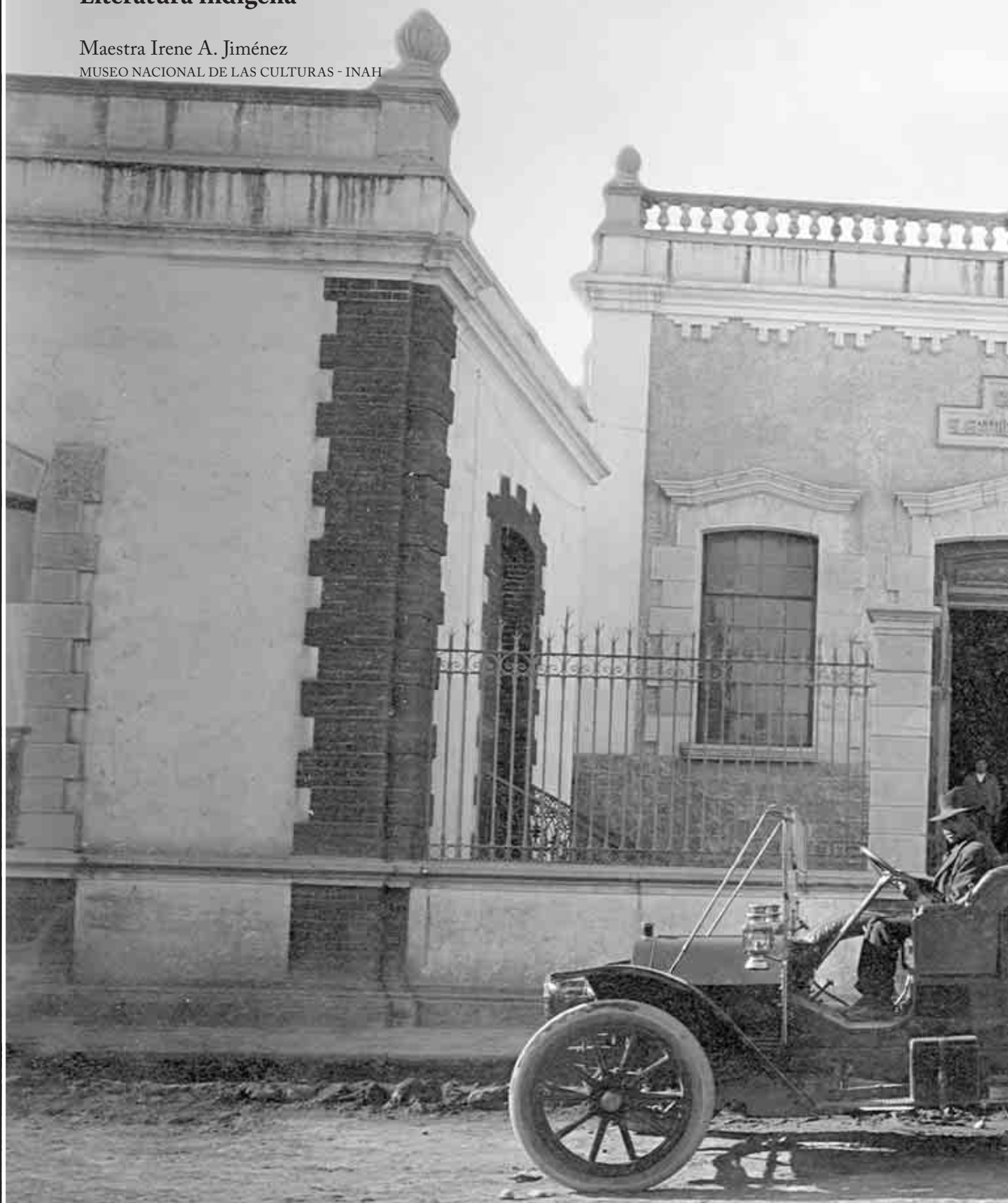
Oficinas de la Compañía eléctrica e irrigadora, en Pachuca, Hidalgo. Ca. 1915. Fototeca de Luz y Fuerza del Centro. Archivo Histórico.
