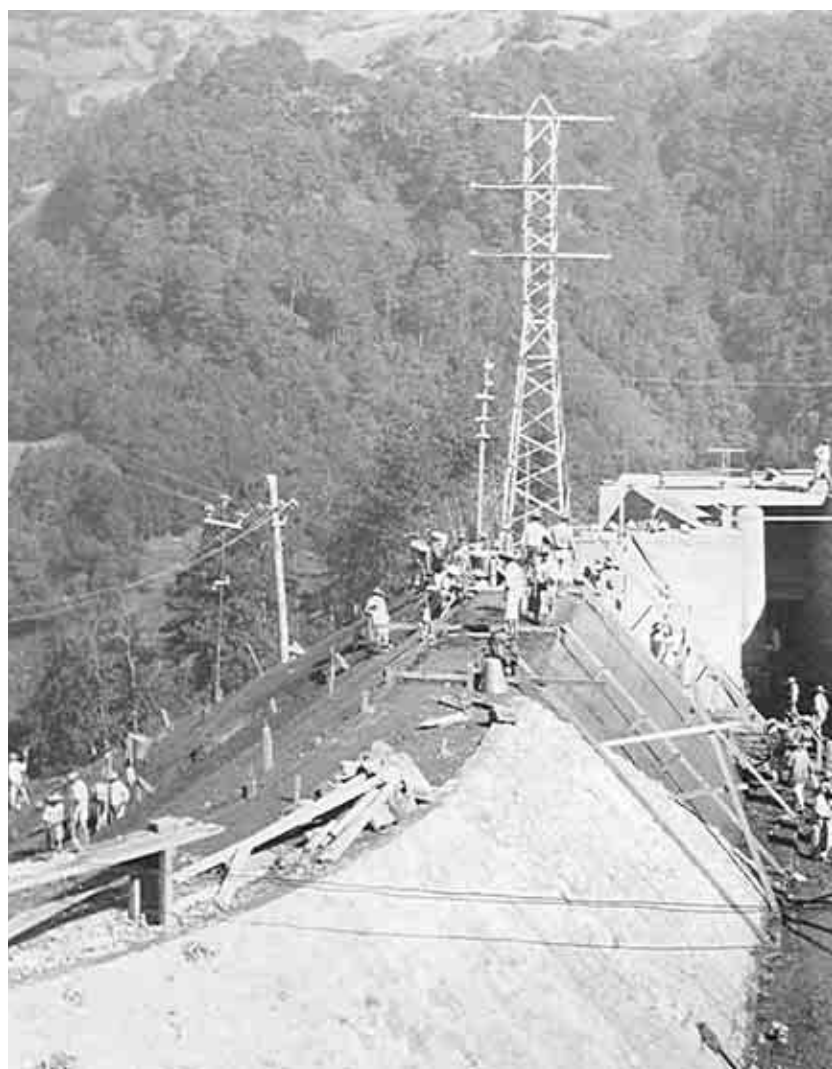
Avance y reto en la obra de Tezcapa, Puebla. Ca. 1927.
