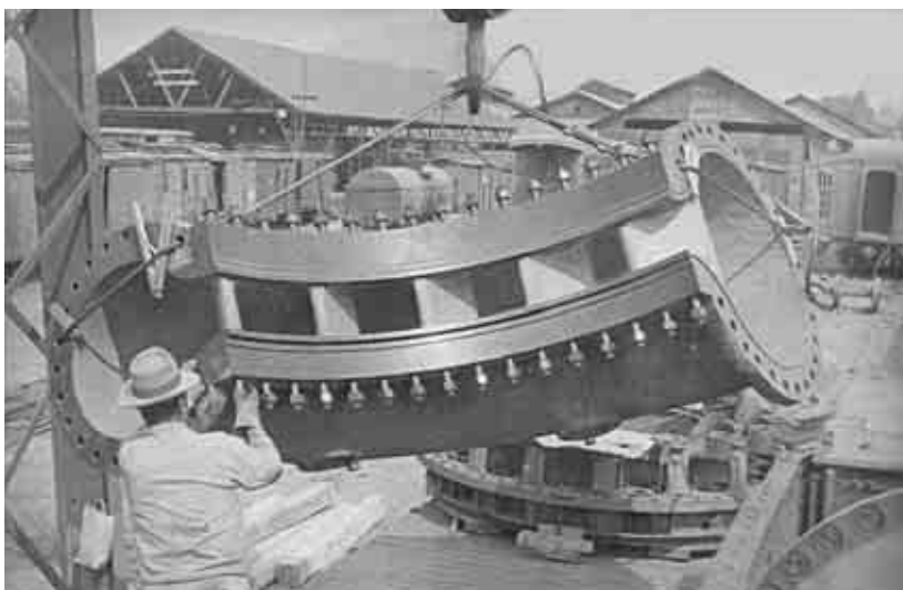
Descargando parte del caracol de la turbina. Planta Lerma, estado de Michoacán. 1949. Fototeca de Luz y Fuerza del Centro. Archivo Histórico.
