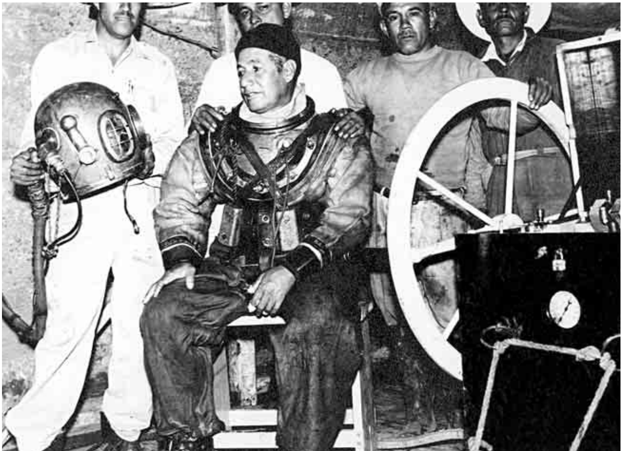
Buzos trabajando en la Torre Toma, presa de Necaxa, Puebla. Junio de 1857. Fototeca de Luz y Fuerza del Centro. Archivo Histórico.
