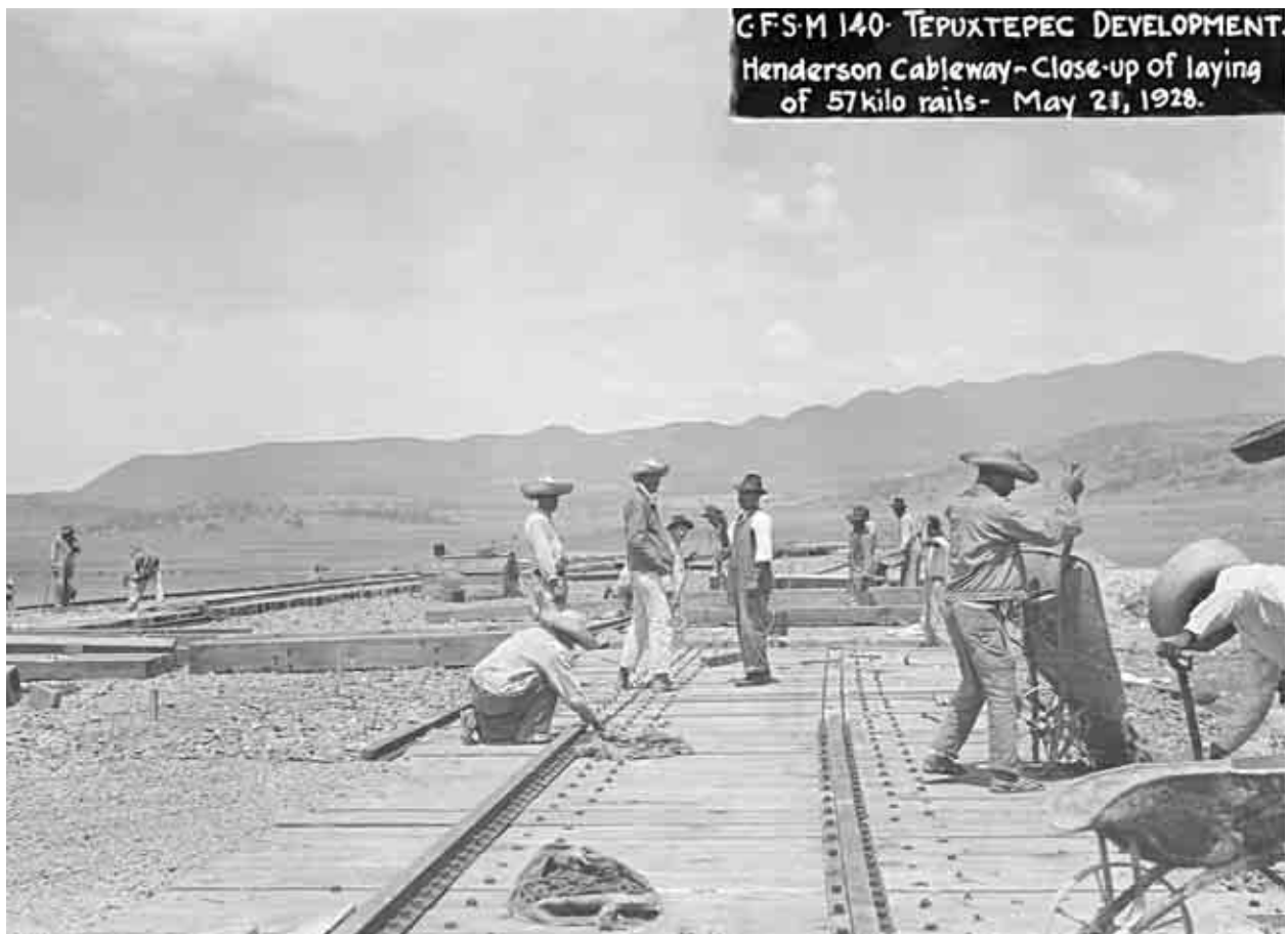
Avances en el tendido de la vía de ferrocarril, kilómetro 58. Tepuxtepec, Michoacán, 1928.
