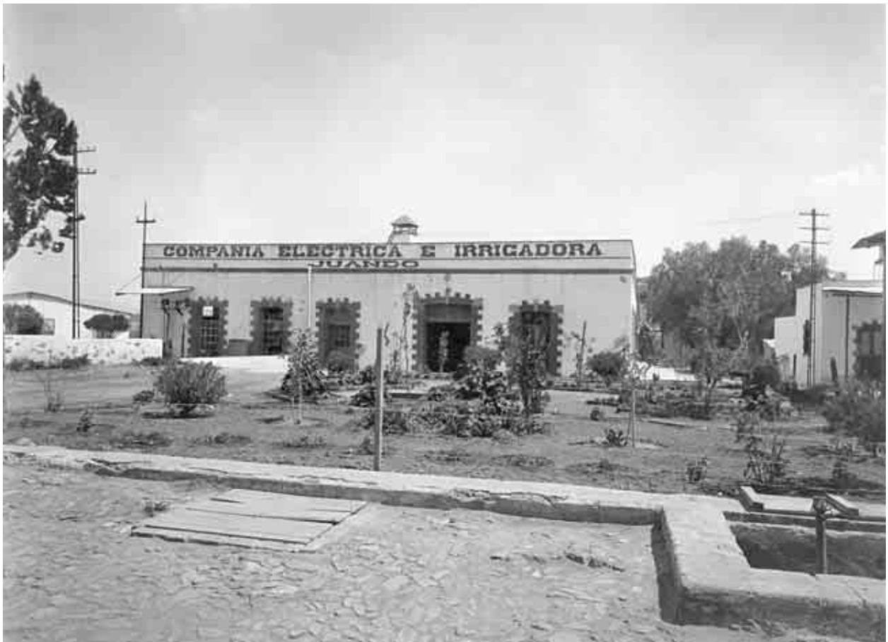
Instalaciones de la Compañía eléctrica e irrigadora Juandó. Hidalgo, México, Ca., 1915. Fototeca de Luz y Fuerza del Centro. Archivo Histórico.
