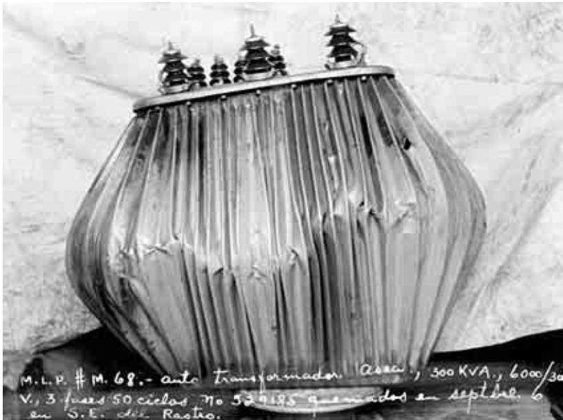
Registro fotográfico de equipos dañados en la Mexican Light & Power Company Limited . Ca., 1930. Fototeca de Luz y Fuerza del Centro. Archivo Histórico.
