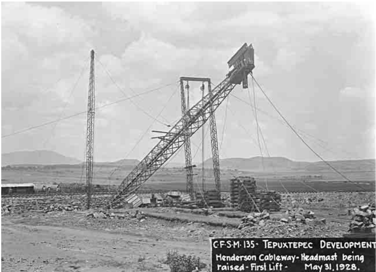
Un reto de la ingeniería. Proceso constructivo de Tepuxtepec, Michoacán, 1928. Fototeca de Luz y Fuerza del Centro. Archivo Histórico.
