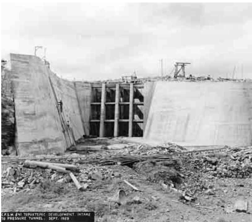
Paredes y túnel de la presa en Tepuxtepec, estado de Michoacán, 1930. Fototeca de Luz y Fuerza del Centro. Archivo Histórico.
