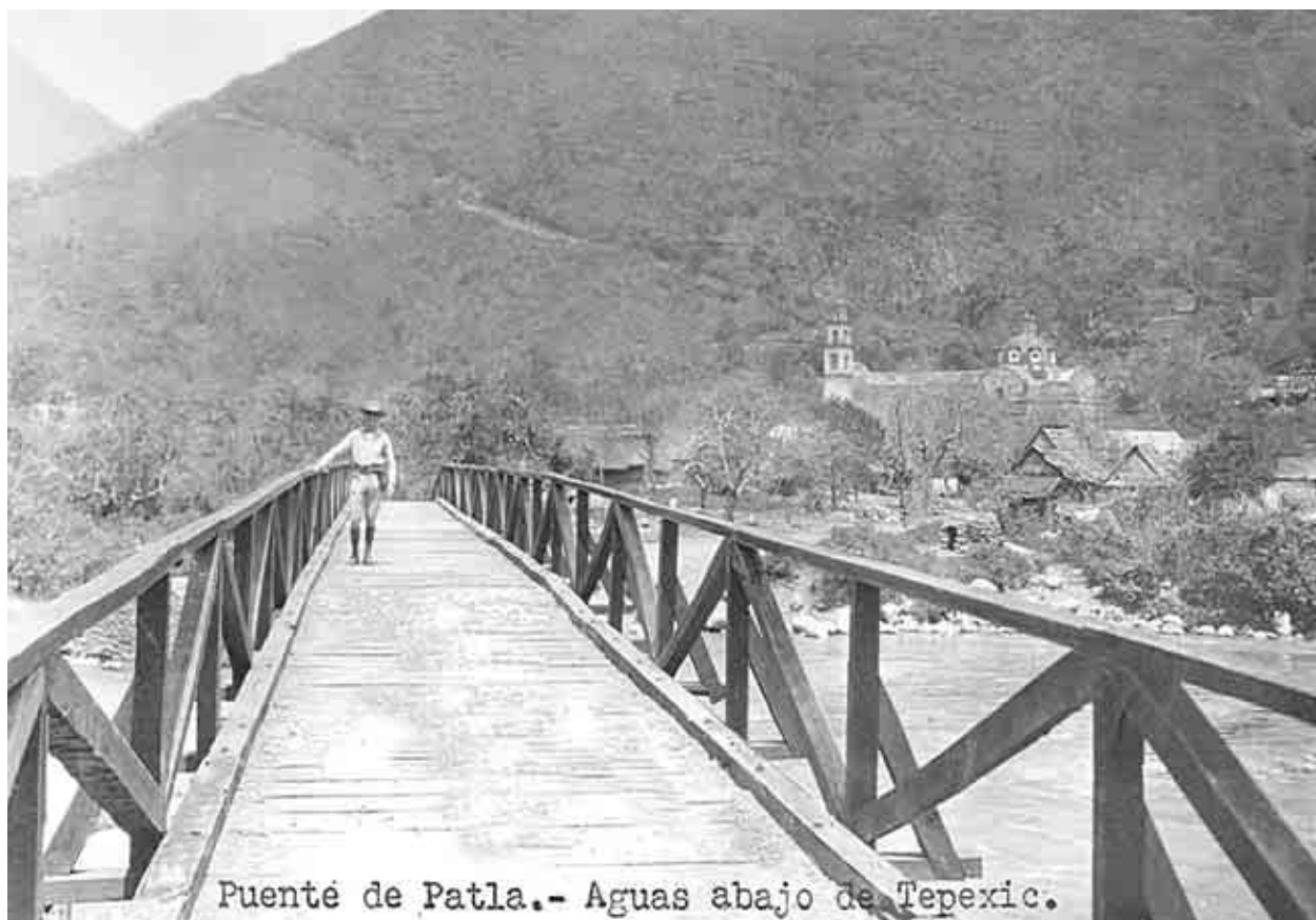
Puente de Patla, aguas debajo de Tepexic, Puebla. 1922. Fototeca de Luz y Fuerza del Centro. Archivo Histórico.
