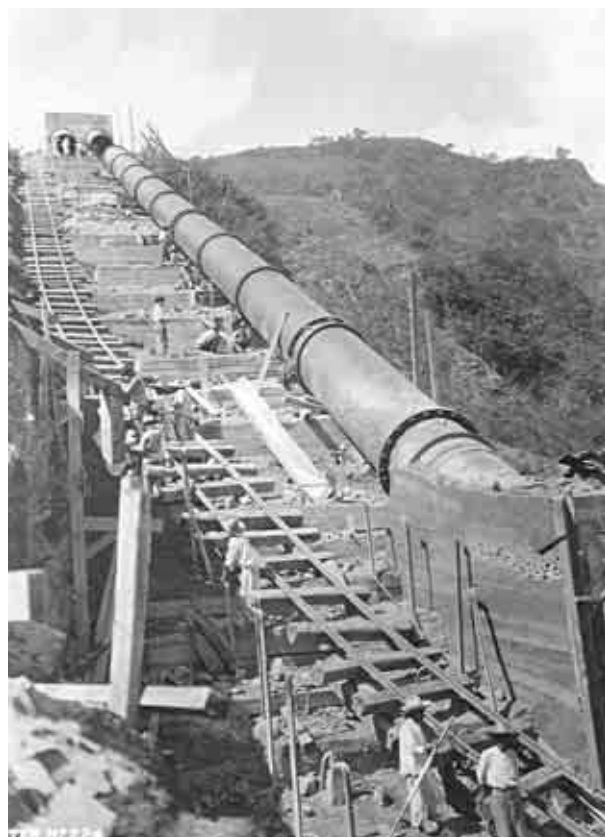
Colocación de la tubería en un terreno accidentado y difícil. Planta Tepéxic, Puebla. Ca., 1922. Fototeca de Luz y Fuerza del Centro. Archivo Histórico.
