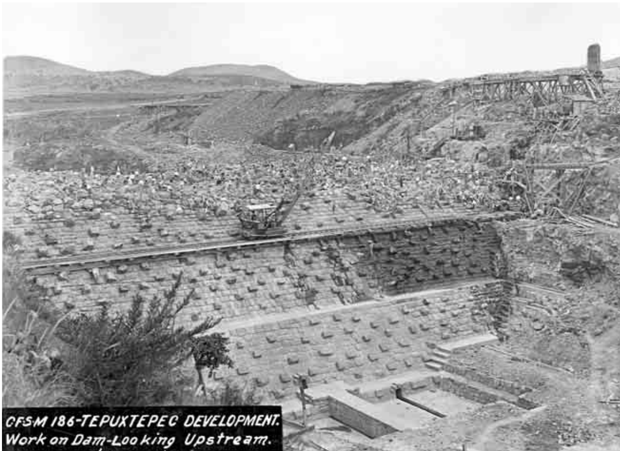
La mano del hombre se impone ante la naturaleza. Proceso constructivo de Tepuxtepec, Michoacán, 1928. Fototeca de Luz y Fuerza del Centro. Archivo Histórico.
