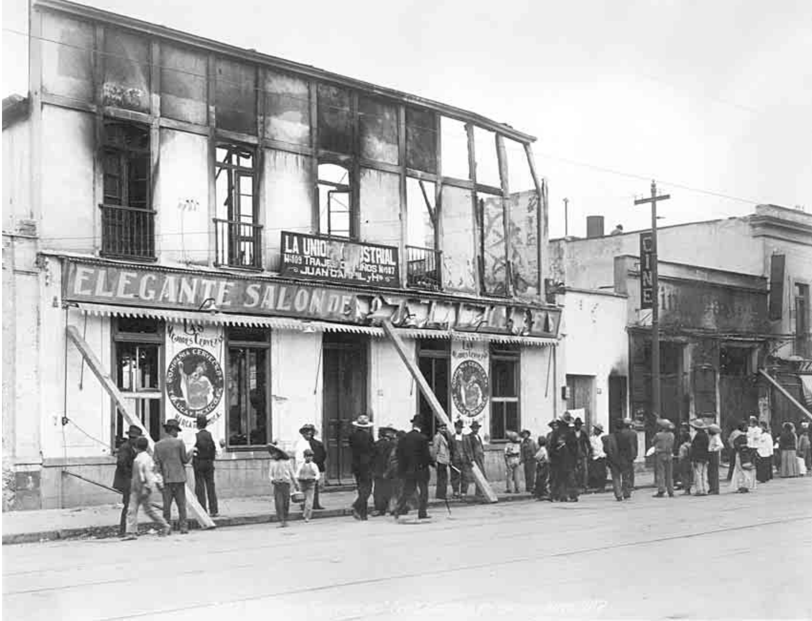
El "Elegante salón de..." a punto del derrumbe. Ciudad de México, febrero de 1913. Fototeca de Luz y Fuerza del Centro. Archivo Histórico.
