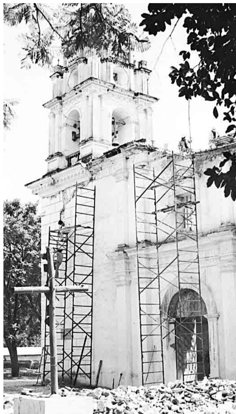
Xochihuehuetlán. Restauración de la bóveda y la fachada principal
