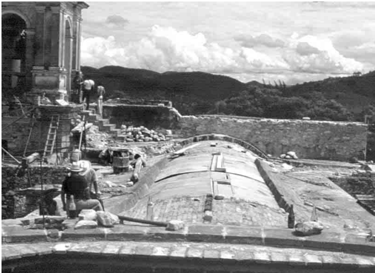
Xochihuehuetlán. Restauración de la bóveda de cañón del templo
