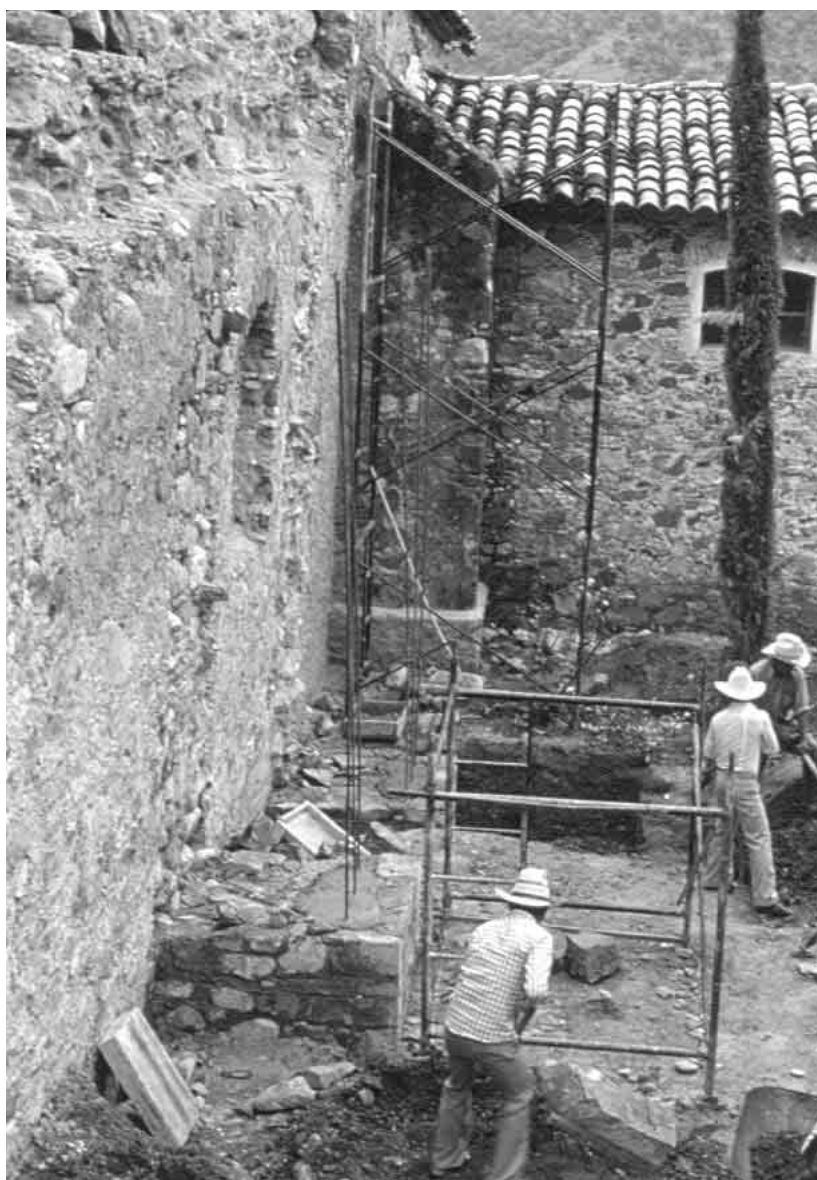
Pozos de sondeo en torno al templo.
