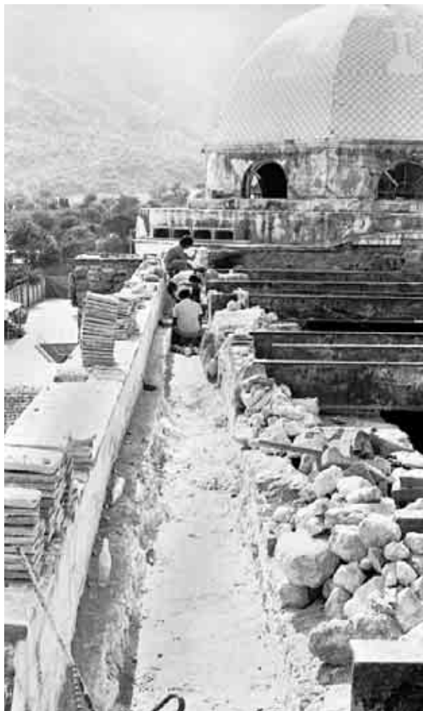
Huamuxtitlán. Restauración del templo. 1982-83
