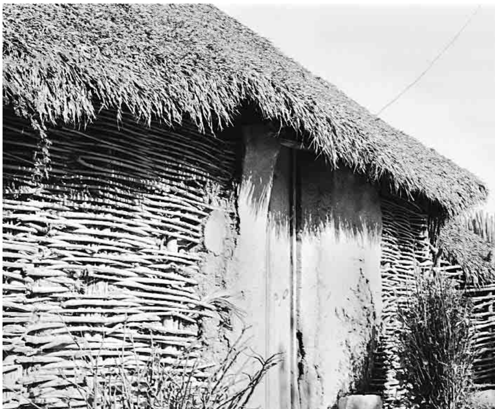
Horcones, varas, lodo, zacate y palma, materia prima de la arquitectura vernácula. Coyahuaco. Nov. 1978.
