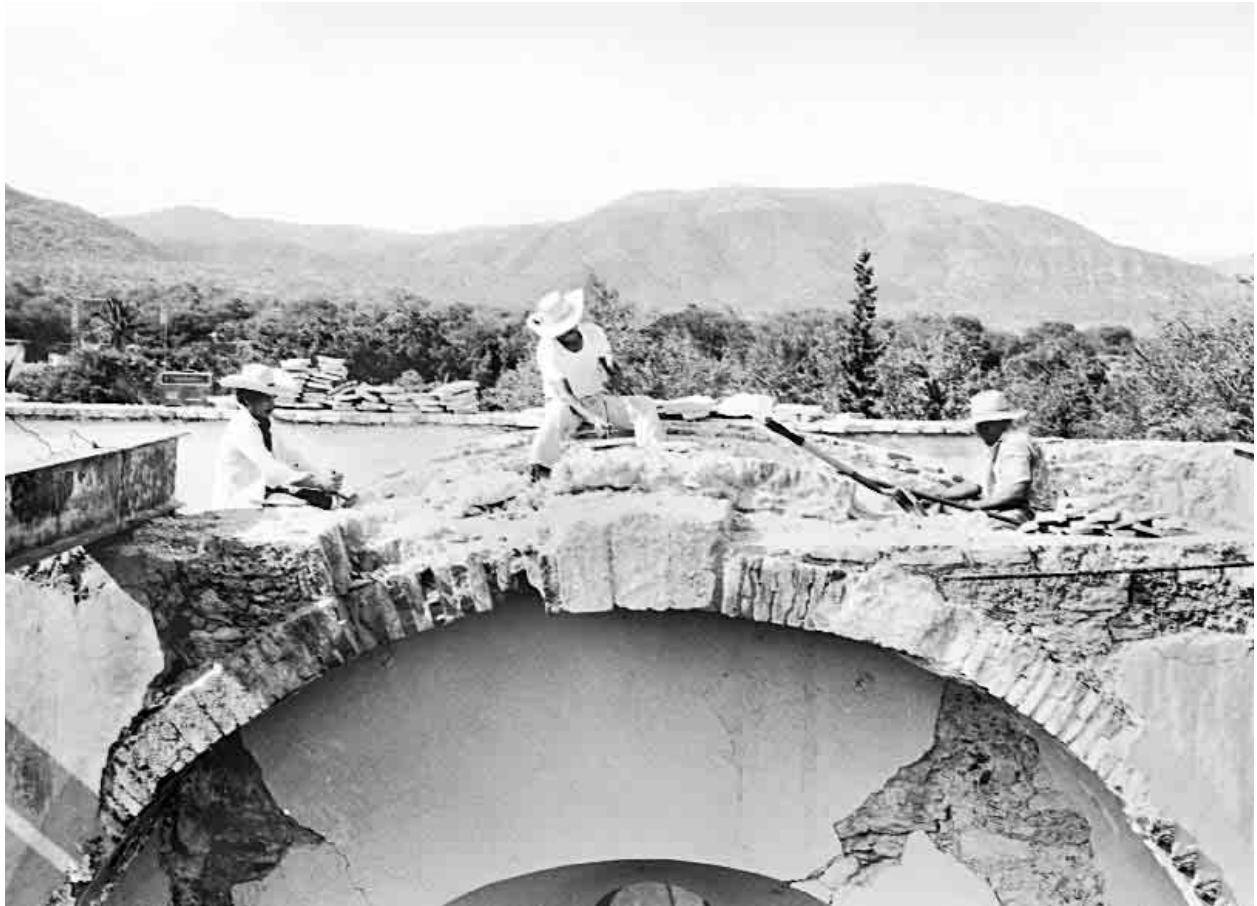
Huamuxtitlán. Restauración del templo. 1982-83
