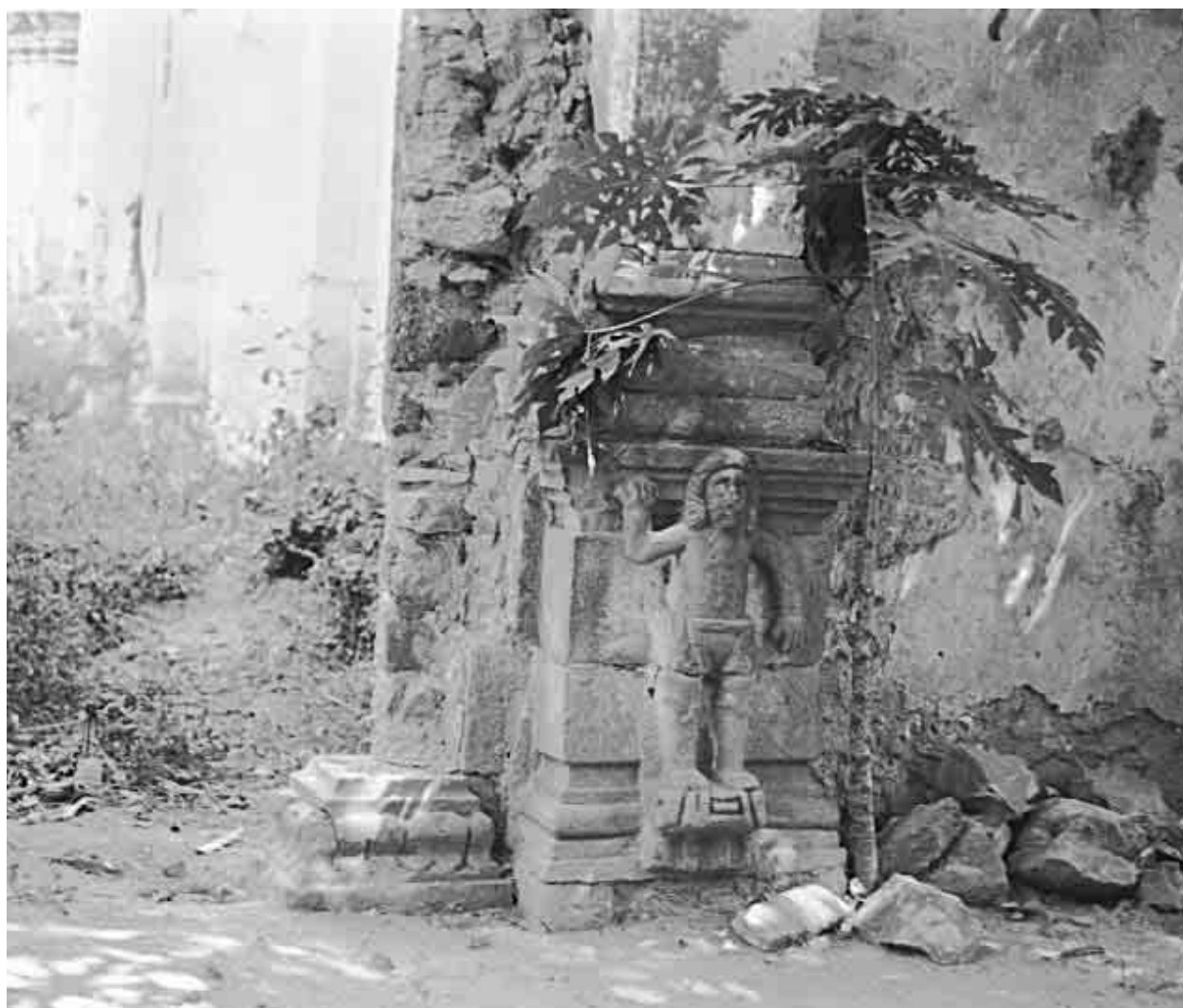
Coyahuaco Municipio de Huamuxtitlán. Base de pilastra derecha de un templo en ruinas, construido a finales del siglo XV ó principios del XVI. 1979-1980.
