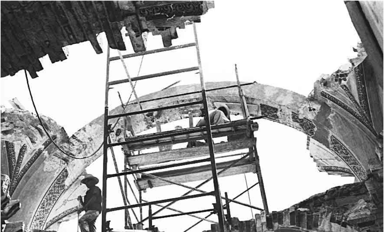
Xochihuehuetlán. Restauración de la bóveda y la fachada principal
