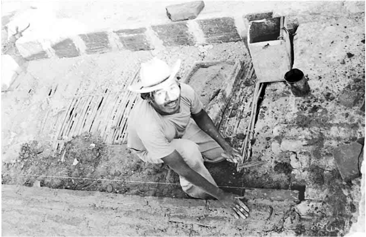
Xochihuehuetlán. Restauración de la bóveda de cañón utilizando carrizo como material de apoyo para darle curvatura. 1982-83.
