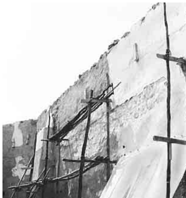
Atlamajalcingo del Monte. Restauración de sus paredes interiores.
