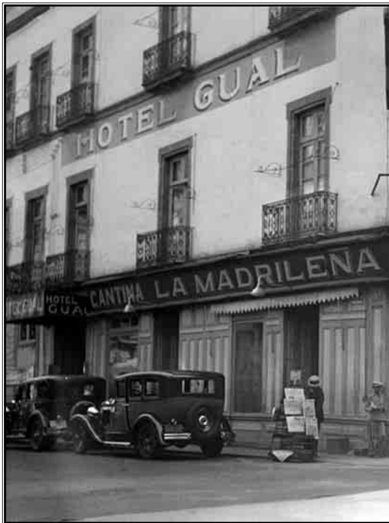
Cantina La Madrileña y hotel Gual. Edificio. © 1249. SINAFO-FOTOTECA NACIONAL.
