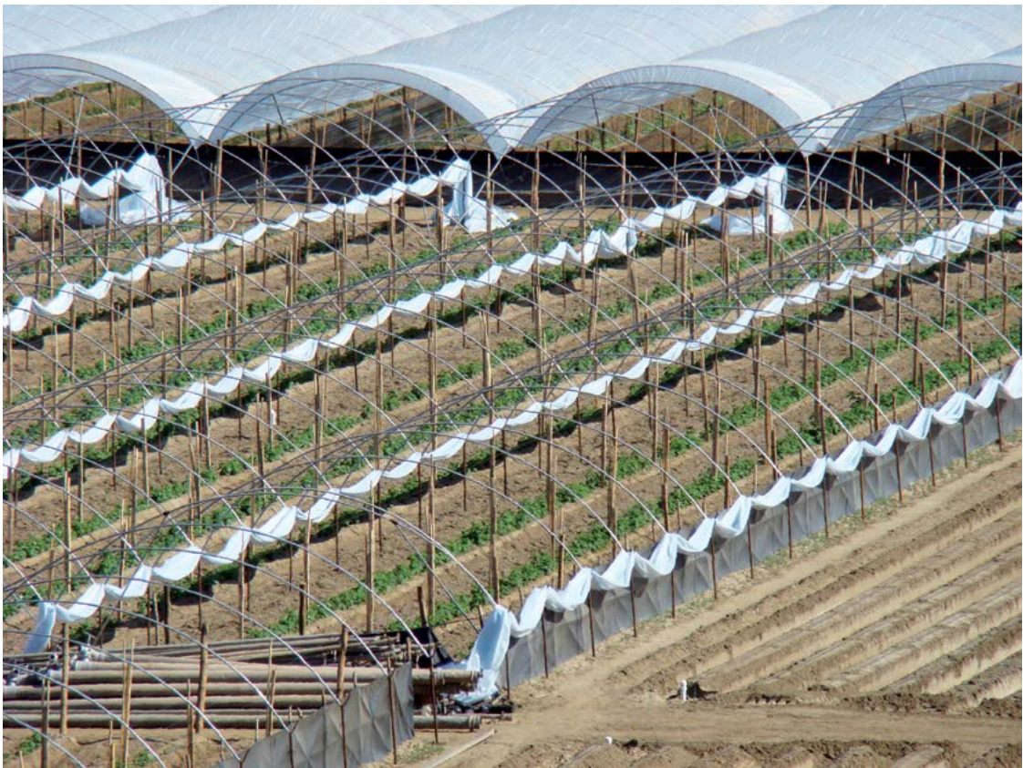
Montaje de túneles altos o macrotúneles en batería, utilizados a fin de proveer las condiciones idóneas para la producción de hortalizas, frutas y flores en el valle de San Simón. Fotografía © Claudia E. Delgado.
