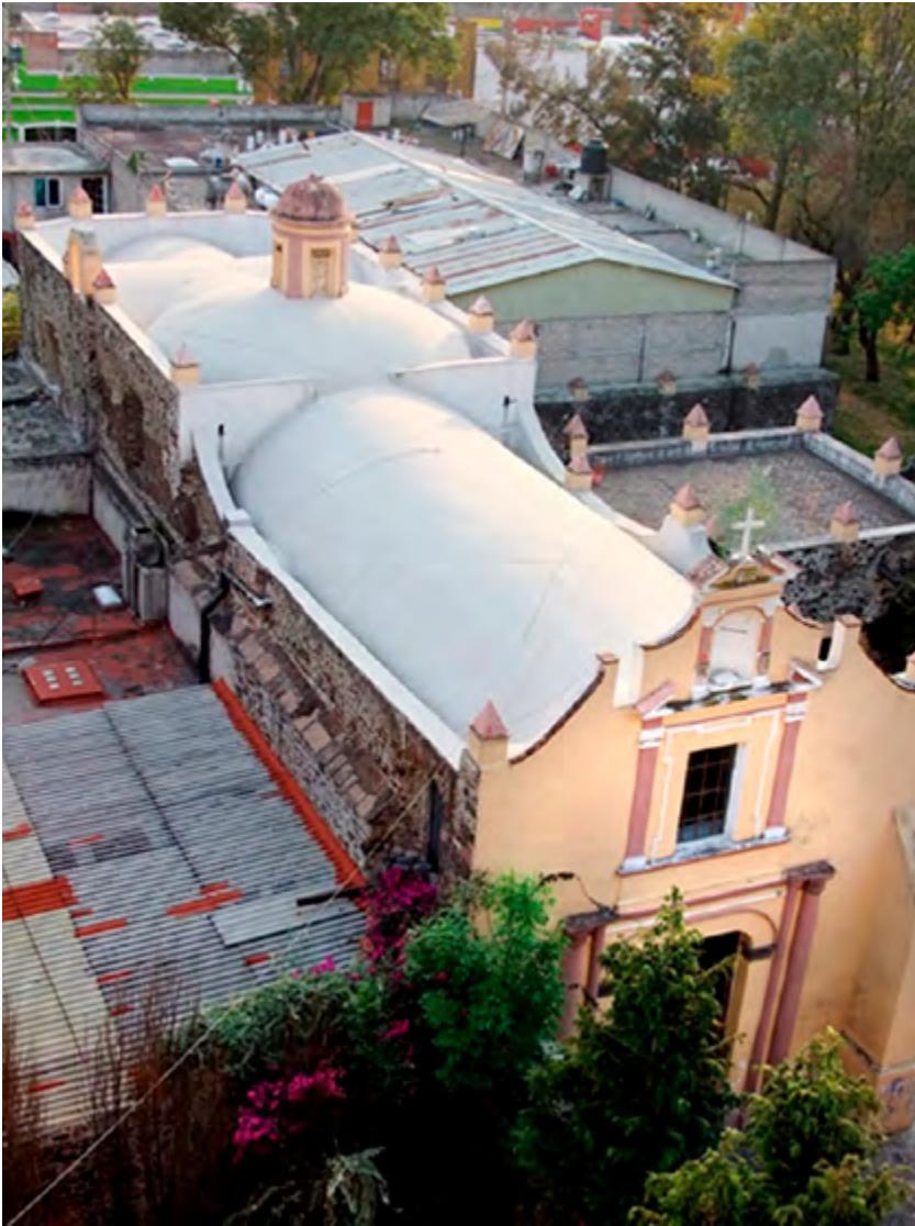
Figura 21. Cubierta mixta de la capilla de la Tercera Orden; el primer tramo es de bóveda de cañón corrido; el segundo, donde está una linternilla, de bóveda de pañuelo, y el tercero, de bóveda con nervaduras. Fotografía de Bogart Olvera Martínez, 2014.
