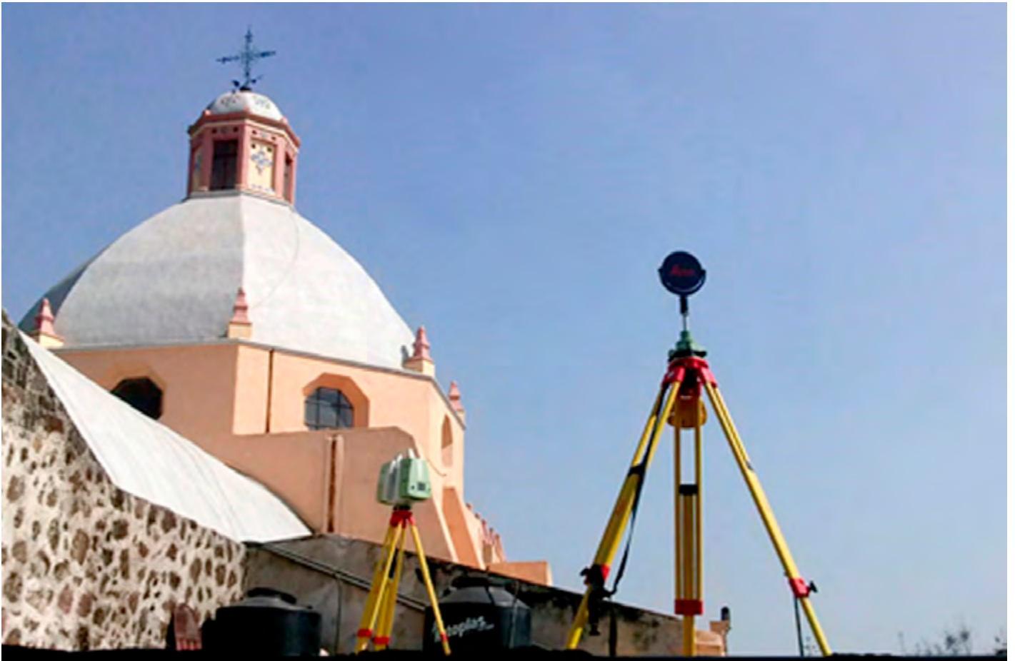
Figura 1. Proceso de escaneo de la cubierta sur del templo de San Bernardino de Siena, Xochimilco. Se observa a la izquierda el escáner láser y a la derecha el tripié que soporta el target del punto georreferenciado. Fotografía de Araceli Peralta Flores, 2014.
