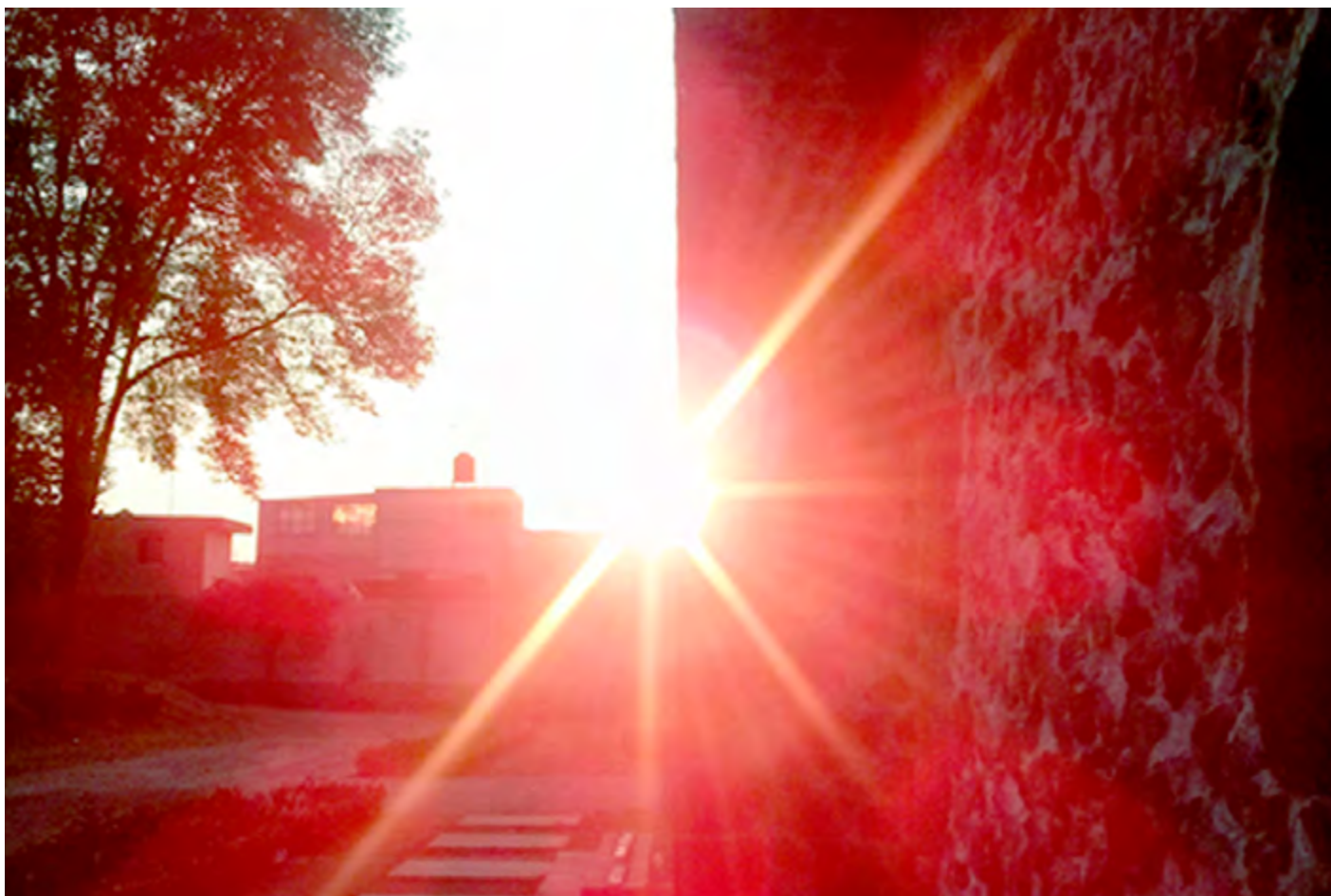
Figura 25. Alineamiento de la salida del sol a las 7:00 a. m. del 24 de febrero de 2014 que va del segundo contrafuerte del templo de San Bernardino de Siena a "la cabeza" del volcán Iztaccíhuatl. Fotografía de Araceli Peralta Flores.
