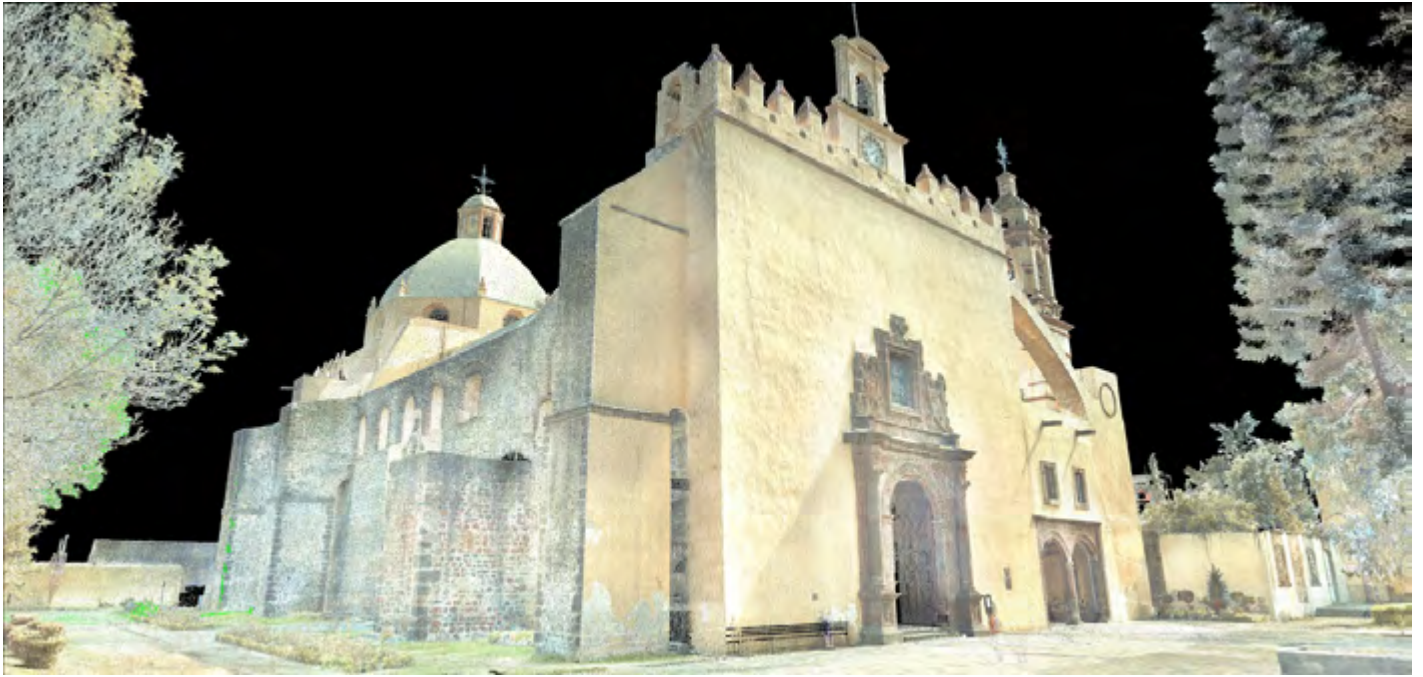
Figura 4. Perspectiva del templo de San Bernardino de Siena, con la tecnología del escáner láser, en donde se aprecia la fachada lateral ubicada al norte y la fachada principal que da al poniente. Imagen elaborada por Apolo Balarama Ibarra Ortiz, del LIAD, 2015.
