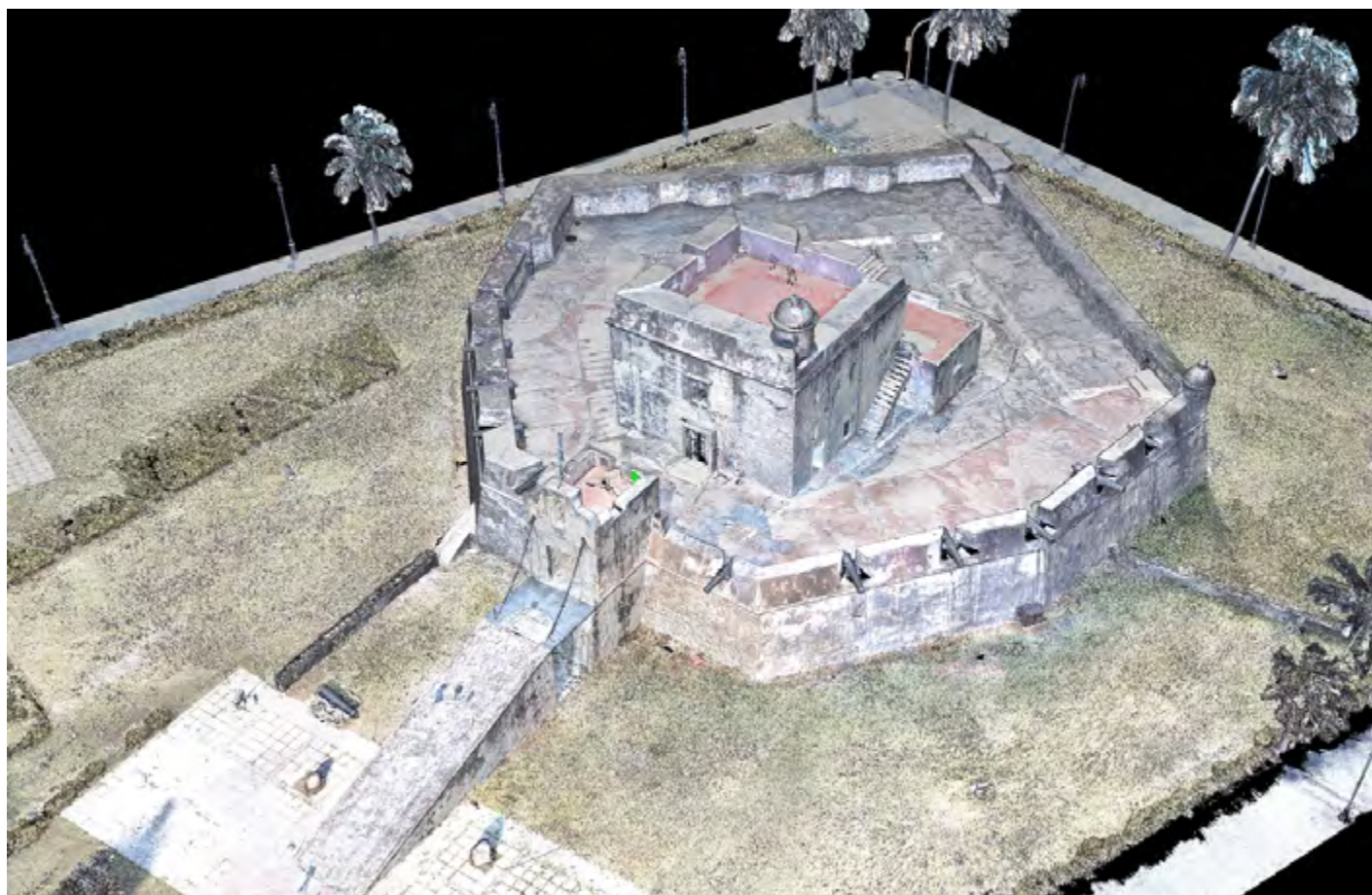
Figura 7. Vista del modelo tridimensional del baluarte de Santiago, obtenido a partir del levantamiento arquitectónico con escáner laser, LIAD-CNMH, 2014.
