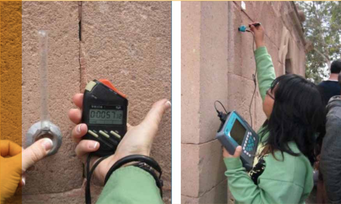
Figura 8. Prueba de absorción de agua con tubo Karsten (izq.), medición de la dureza de la piedra con martillo Schmidt digital (der.). Fotografía. N. Pérez.
