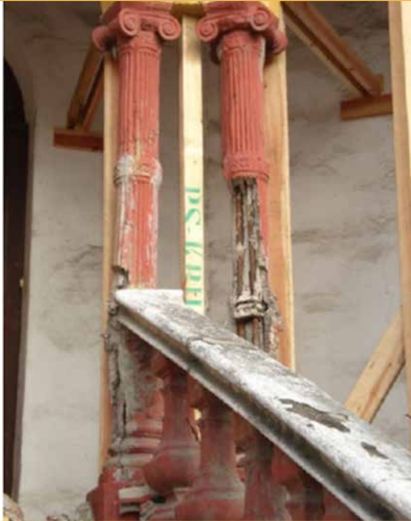
Figura 7. estructuras metálicas con oxidación del hierro. H. Orea.
