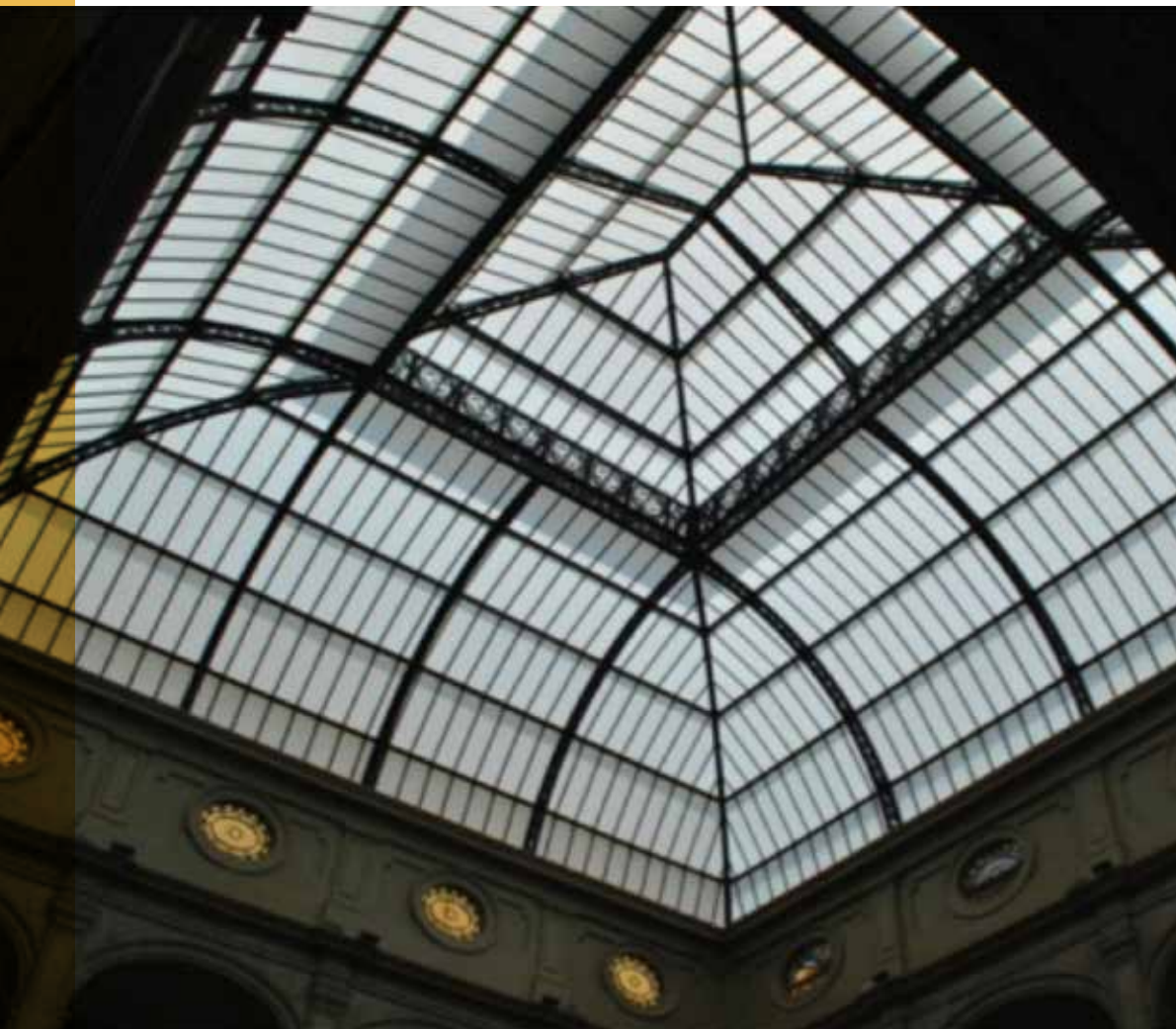
Figura 9. Vista desde el interior del patio al concluir el proceso de intervención. Fotografía de X. Garibaldi, 2011.
