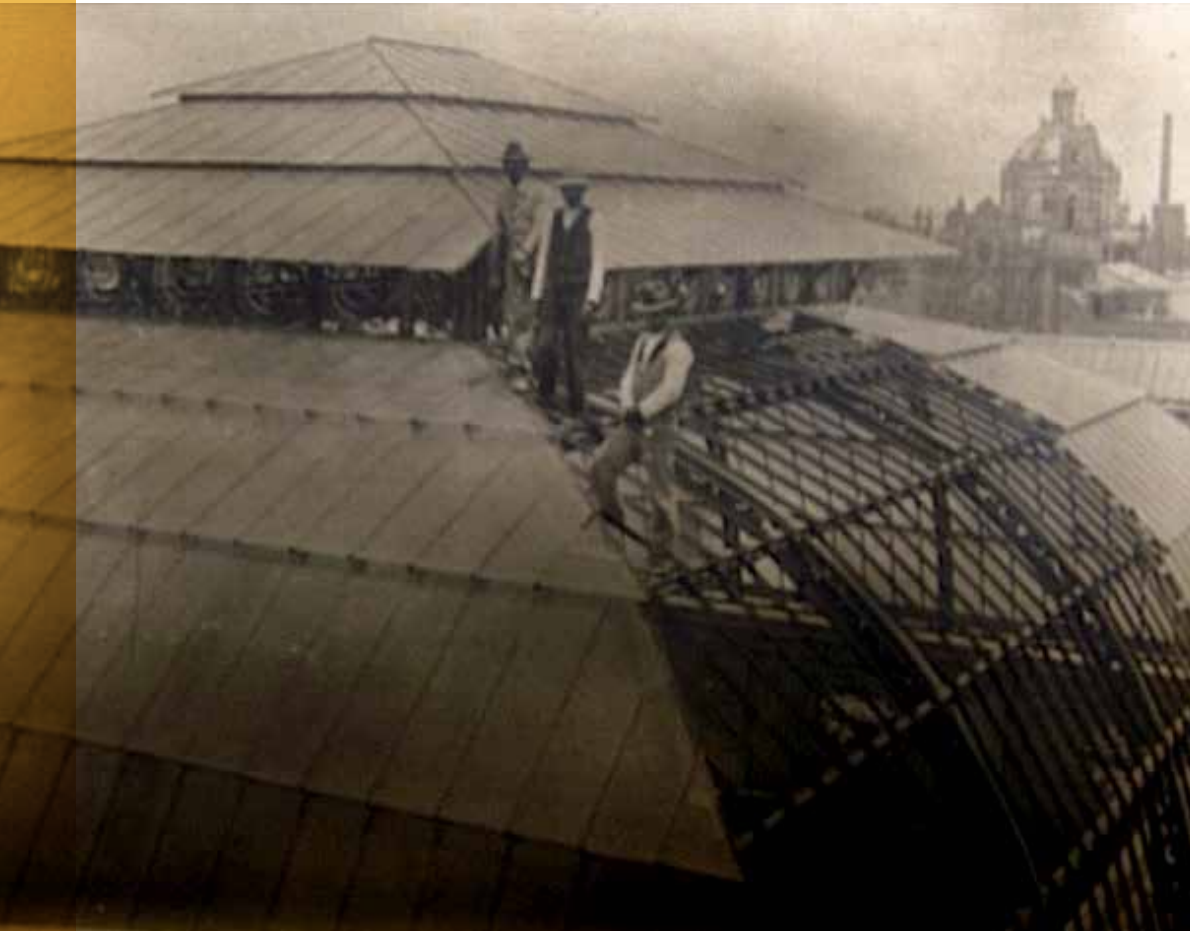
Figura 4. Imagen que muestra con claridad los dos cuerpos que conforman la estructura domo, la parte baja resuelta en armaduras curvas que se concentran en el anillo de compresión y la cubierta superior con diseño de cuatro aguas. 1913. Colección ENAP/ UNAM (Archivo Gráfico de la Academia de San Carlos. Imagen 08-666726, 2009).
