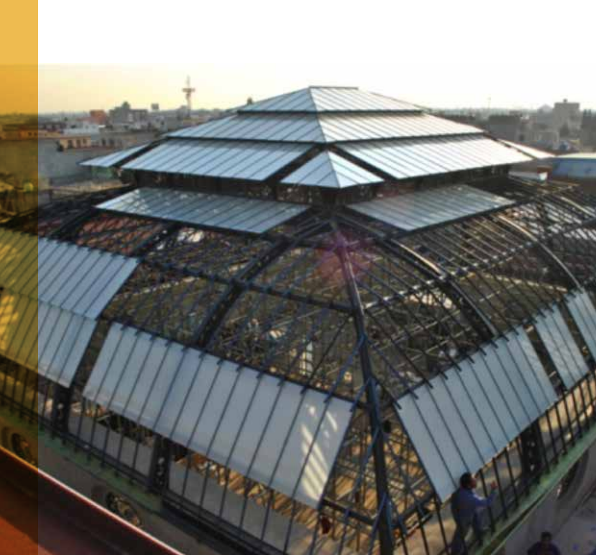
Figura 8. Vista del proceso para la sustitución de cristales. Fotografía de X. Garibaldi, 2011.
