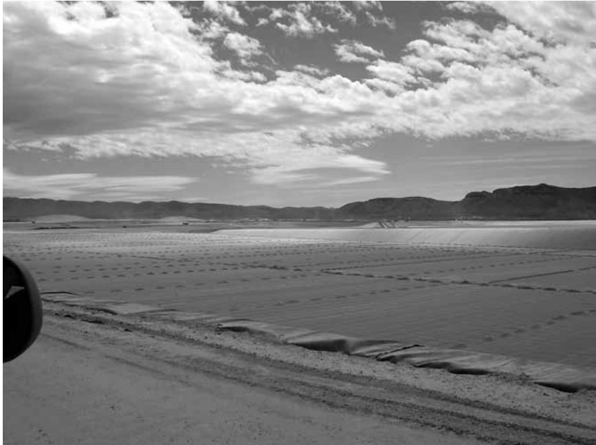
Fig. 4 Vista parcial de la presa para el depósito de las aguas residuales (foto Panico).
