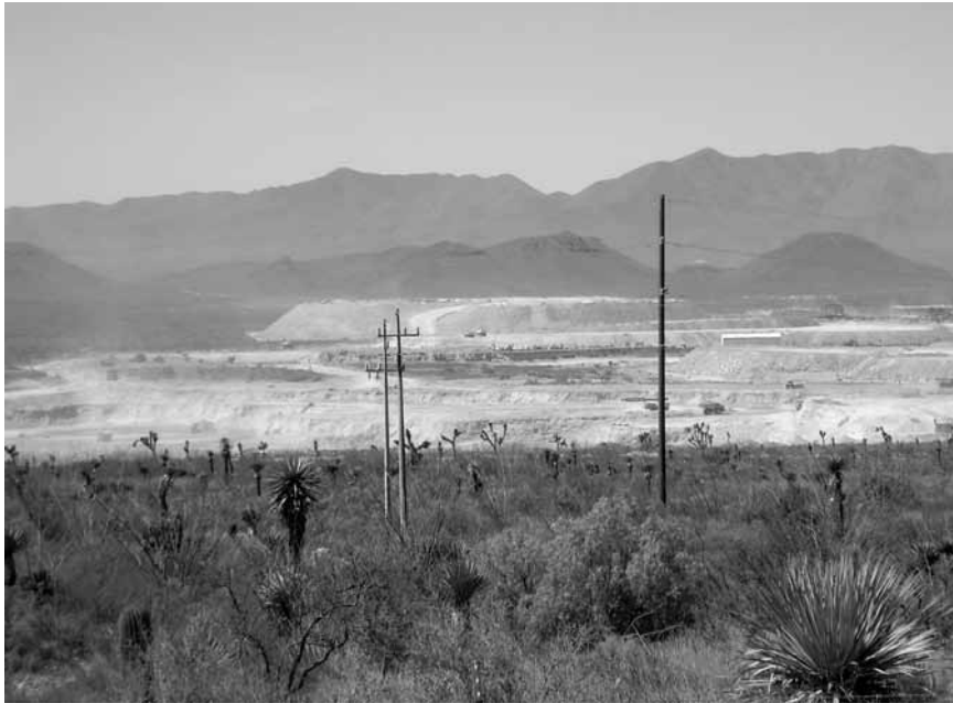
Fig. 3 Vista panorámica de la planta industrial de la Minera Peñasquito (foto Panico).
