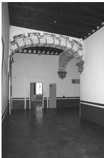
Fig. 8. Claustro alto con cubiertos de viguería.
