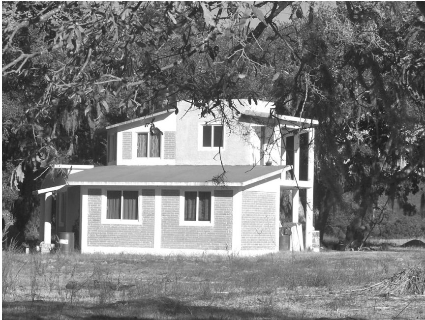
Fig. 2. Vivienda nueva en el municipio de San Miguel Huautla (foto: G. Boils, diciembre de 2008).
