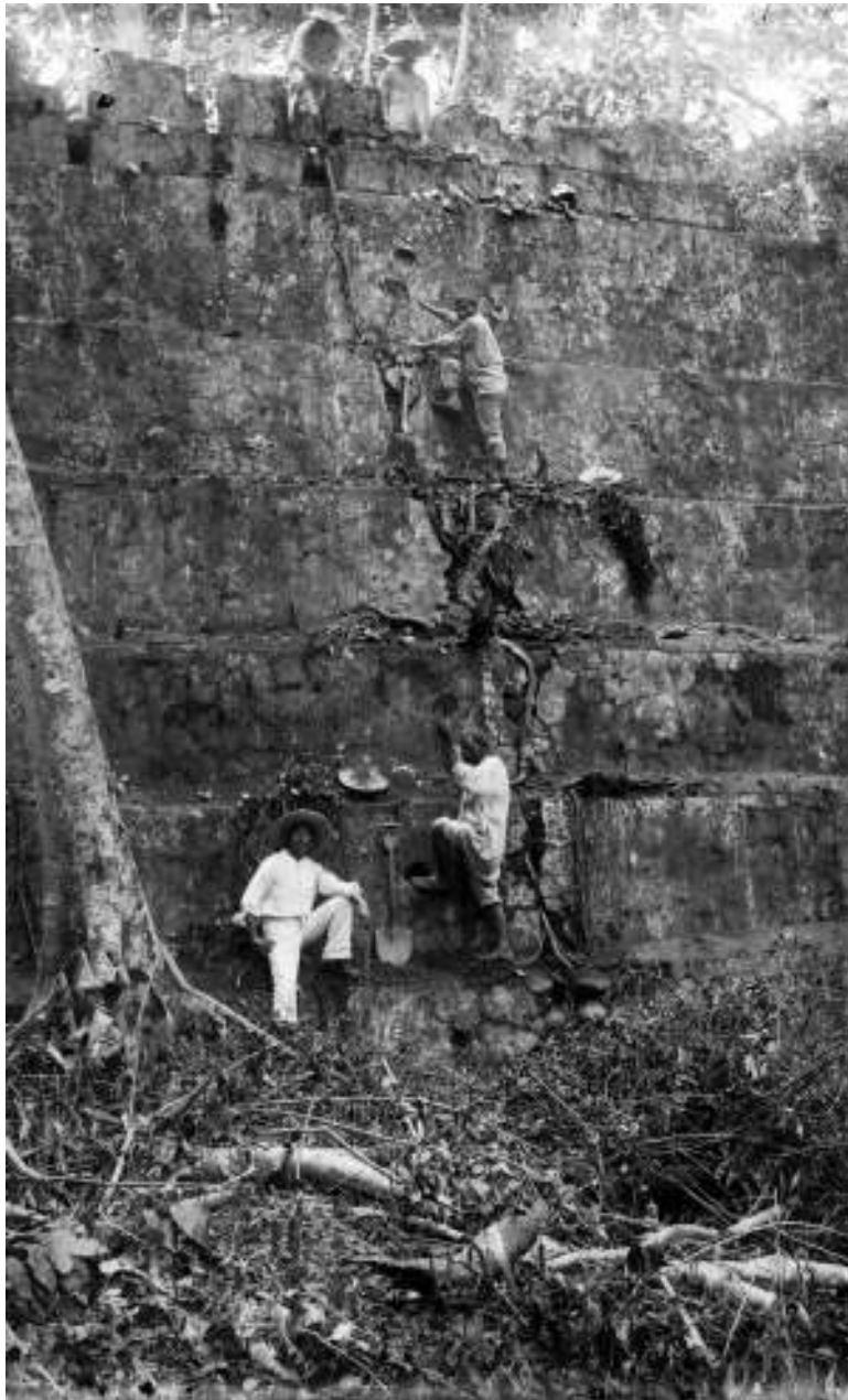
Foto 6. Trabajos en una estructura, Rafael García, Cempoala, Veracruz, agosto 1890-abril 1891. Inv. 351720, Sinafo-INAH.
