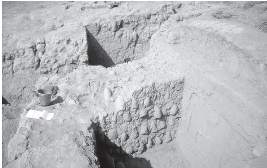
Fig. 16. Excavación del Templo Escalonado mostrando su friso con diseños escalonados (foto de G. Orefici, 1988).
