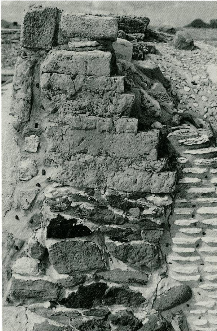
Fig. 3b. Acercamiento de los adobes quemados, acceso a la Sala 1 del Palacio Quemado (Foto: Juan Carlos Equihua).
