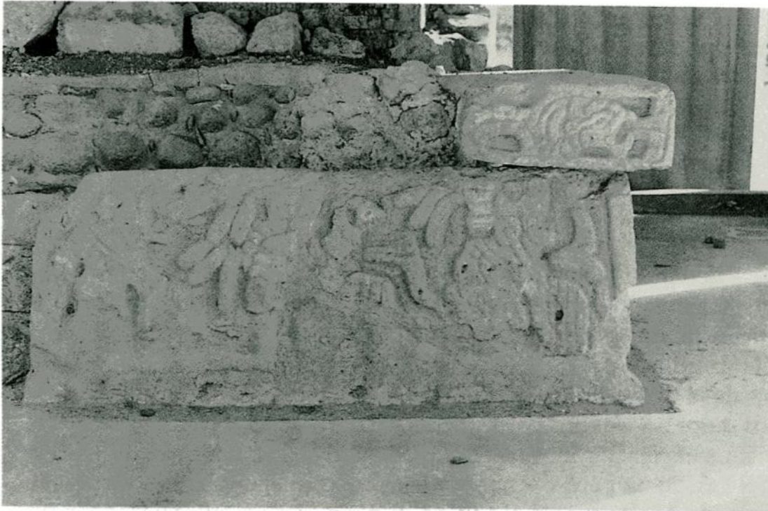
Fig. 5. Banqueta con frisos afectados por el fuego localizada sobre la entrada sur de la Sala 2 del Palacio Quemado (Foto: Juan Carlos Equihua).
