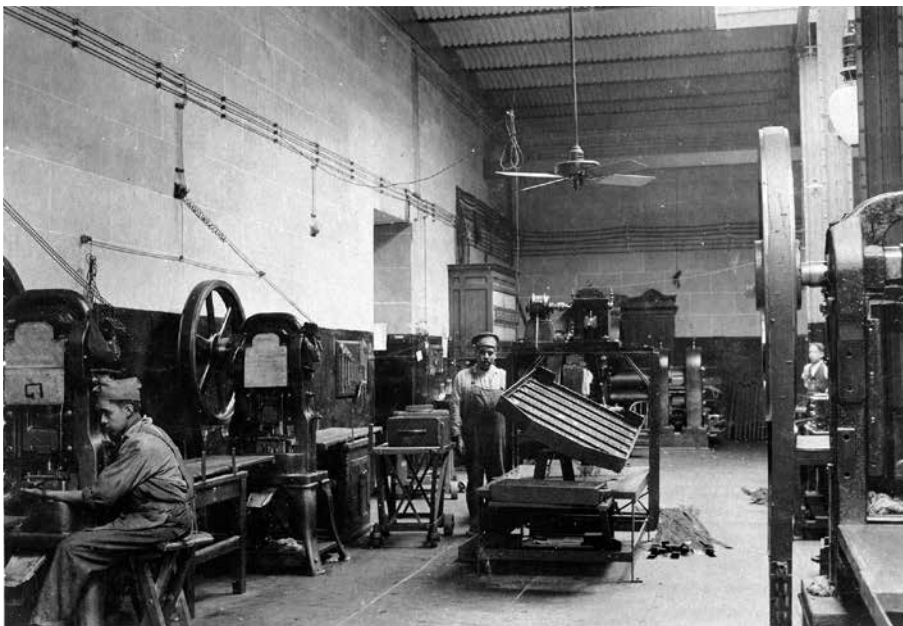
8. Corte de cospeles. Un operario en primer plano hace pasar láminas que ya han pasado las tres etapas de laminación a través de una prensa de corte, lo que da origen a los cospeles. Al centro de la toma, otro operario junto a una “zaranda” de fabricación local: se trata de una criba mecanizada con la que eran eliminados los cospeles “mochos”, producto de un corte defectuoso.
