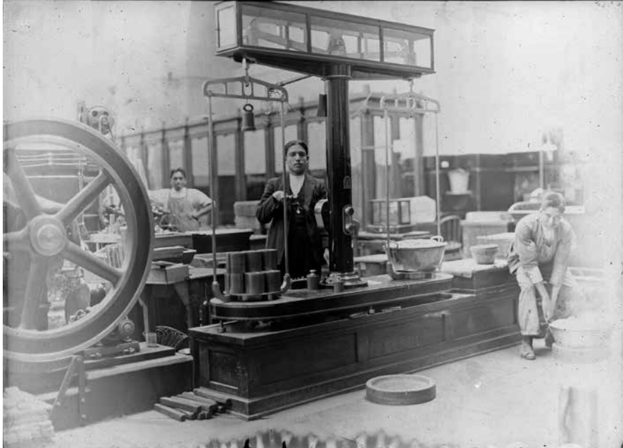
13. Balanza de control. Un operario verifica el peso de los materiales con su balanza de control en la sala de amonedación. Estos instrumentos de alta precisión (que detectan diferencias de una milésima de gramo en pesadas de hasta 500 kg) comenzaron a fabricarse en la Casa de Moneda desde la segunda década del siglo XX, bajo la guía del ingeniero Francisco Valdés, director del establecimiento de 1915 a 1942. Ésta era la primera fase del proceso de “revisión y cuenta”; luego las monedas serían sonadas (para verificar que tuvieran su tintineo característico), y después contadas y embolsadas en talegas de lona.
