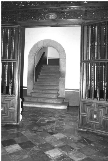
Fig. 5. Escalera hacia el jovenado.
