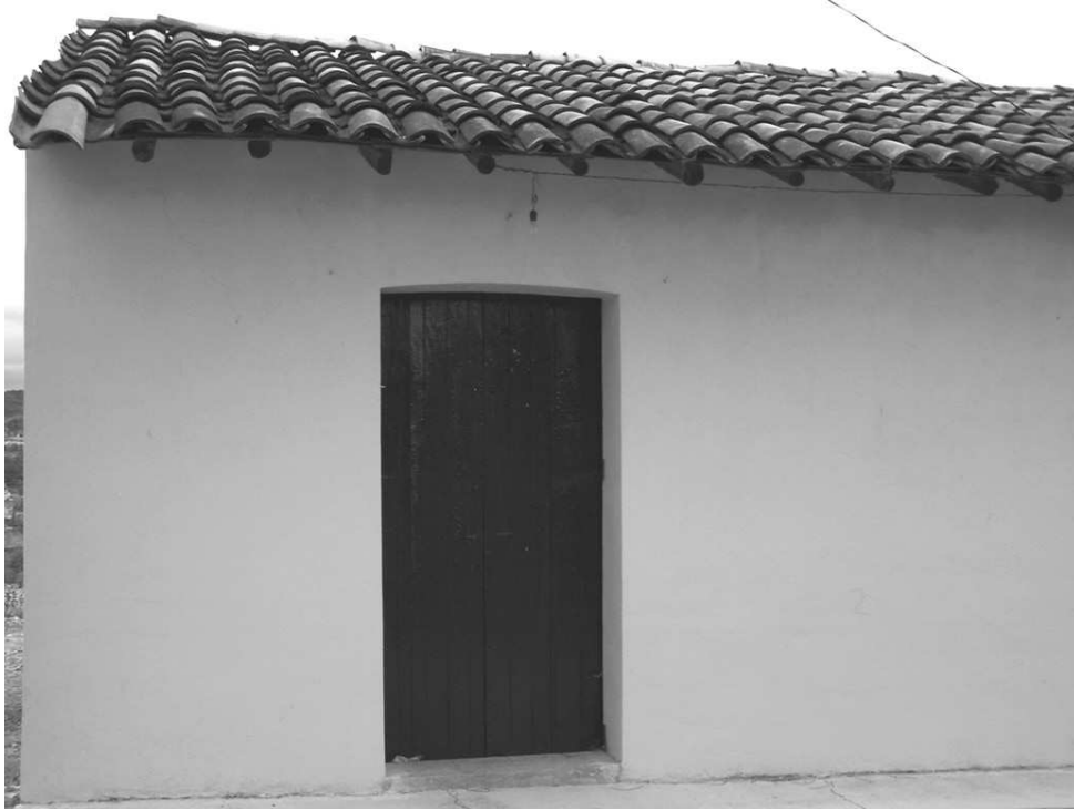
Fig. 8. A veces los cambios en la vivienda son sólo de aplanado y pintura. Vivienda en Santa Magdalena Jicotlán, Oaxaca (foto: G. Boils, febrero 2007).
