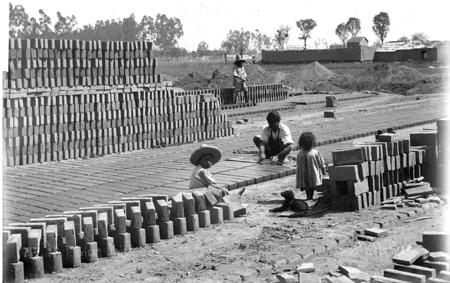
5. Ch. B. Waite, Ladrilleros o adoberos en su faena, ca. 1908. Inv. 120254, Sinafo-INAH.
