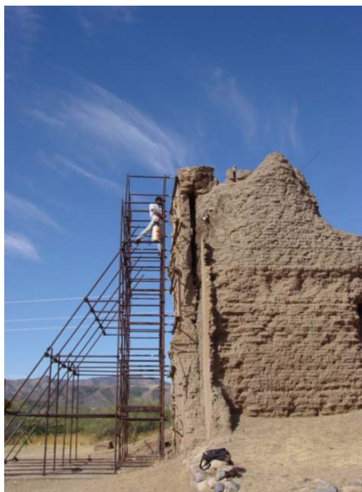
Fachada desde el este
