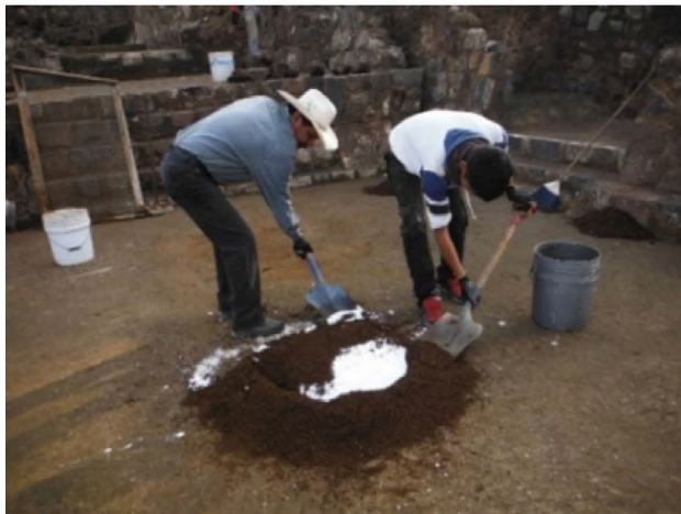
Proceso de elaboración de argamasa de cal con tezontle de San José de los Laureles y tepetate y mucilago de nopal, de San Andrés Cuauhtempan. (Fondo PICZAT 2016).
