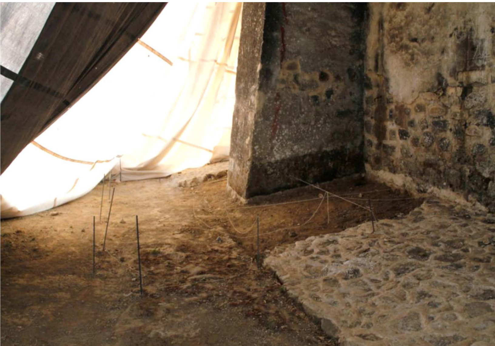
Aspecto del área de exploración al comienzo de la excavación en el contrafuerte No. 4.
