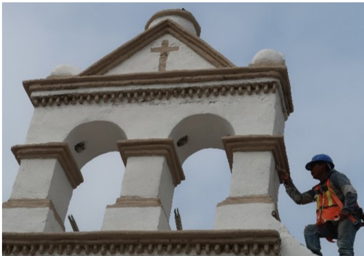
Capilla El Calvario, Cuauhtempan, Tlayacapan, restaurada sin daños del sismo.
