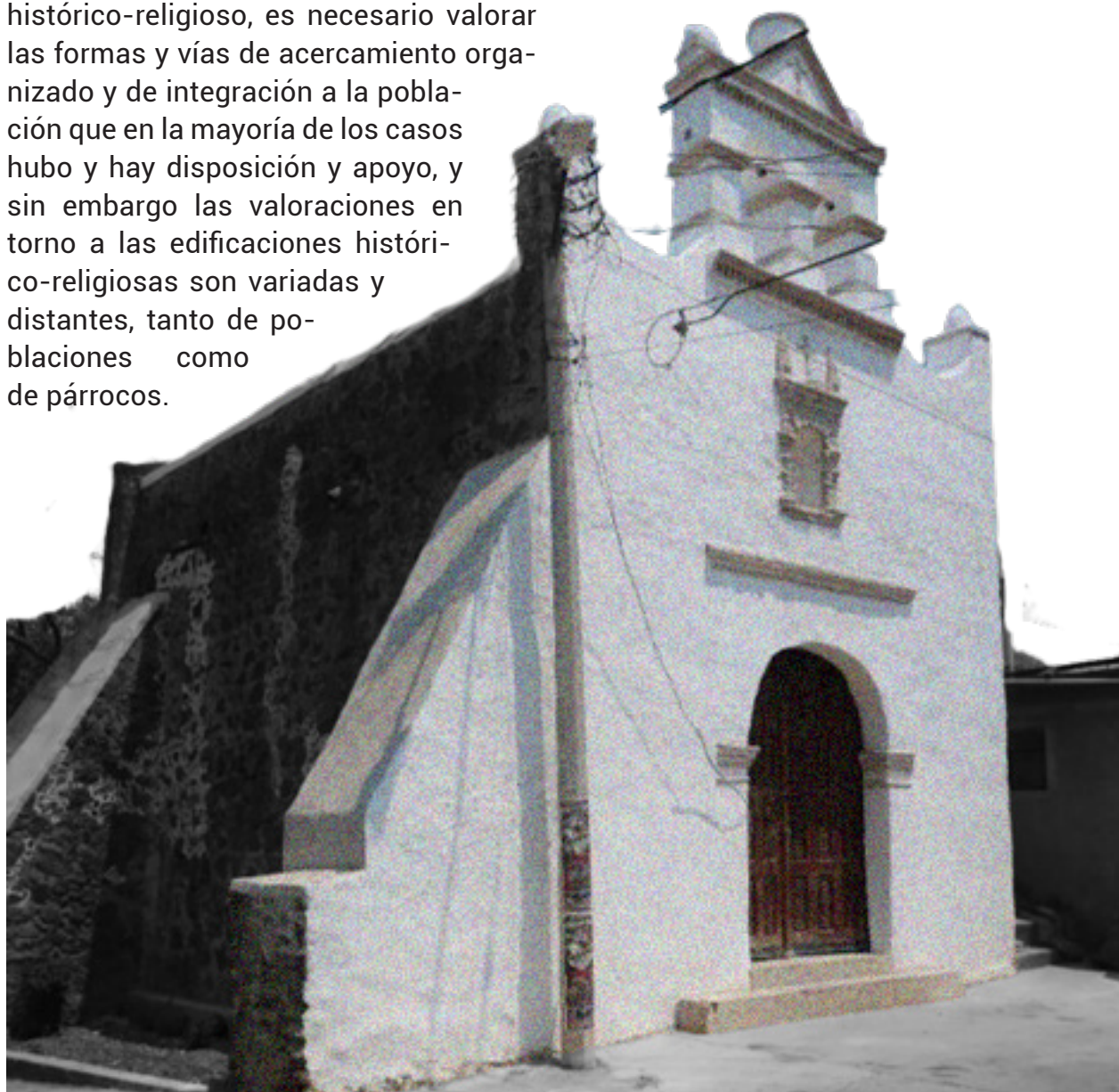
Capilla El Calvario, Cuauhtempan, Tlayacapan. después de los trabajos de restauración.
