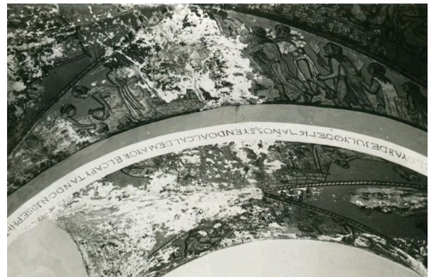
Detalle de la bóveda con pintura decorativa durante los trabajos de rehabilitación del nuevo museo regional Cuauhnáhuac. 1970-1972. Fototeca "Juan Dubernard". Centro INAH Morelos.
