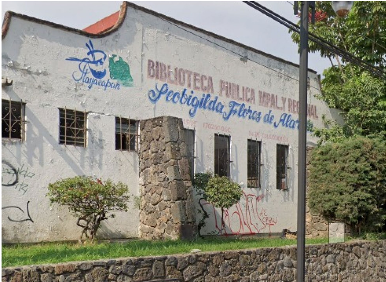
Aspecto de la fachada sur sobre la calle Benito Juárez, de la Biblioteca Pública Municipal y Regional Leobigilda Flores de Alarcón (Fondo PICZAT 2012), la cual fue demolida para la construcción del Centro de Desarrollo Comunitario de Tlayacapan.
