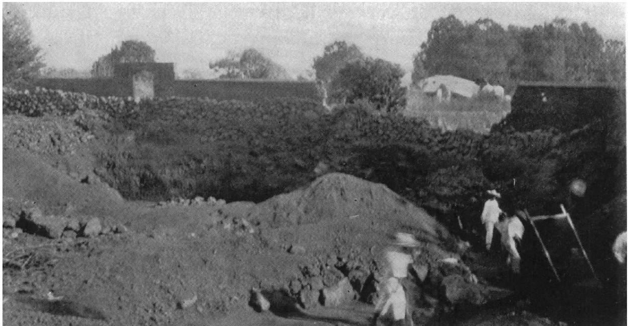
Vista hacia el sureste desde el interior del predio de la ladrillera "Tejería Vieja". En primer plano se observa el área de extracción de arcilla y algunos trabajadores vestidos de manta y sombrero, así como un harnero; más atrás limita el predio un tecorril, que sirve de límite al camino a Tepoztlán, mientras que su otro límite lo compone un muro probablemente de mampostería o adobe en cuyo lienzo se observa un acceso con un arco, al fondo se observan edificaciones y una alta arboleda. En esa área se realizaron las excavaciones arqueológicas. (Vaillant y Vaillant 1934:15)
