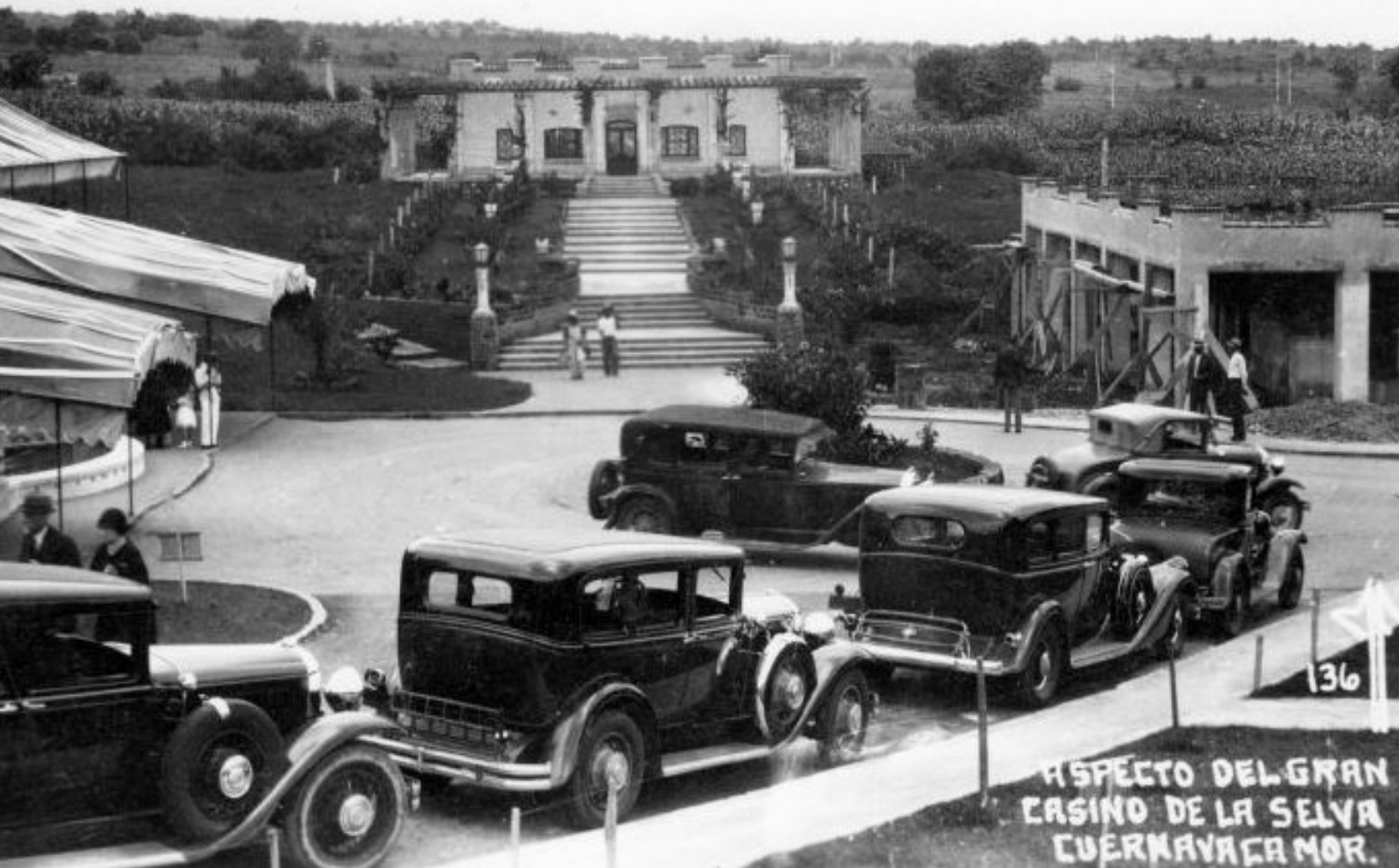
Aspecto del Casino de la Selva de Cuernavaca, alrededor de 1933, los accesos con lonas a la izquierda pertenecen a la nave principal y a la derecha se ve el bloque habitacional en construcción, la vista al fondo es hacia el noreste, y ya existiría también la rotonda del acceso principal (Tomado de https://www.mexicoenfotos.com/MX14271628900232 Ca. 1931). Aproximadamente es el aspecto que tendría el lugar cuando los Vaillant realizaron sus exploraciones al este de este Casino de la Selva, en la Tejería Vieja.
