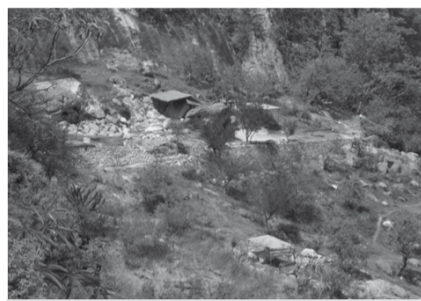
Figura 3. Vista general del las cubiertas colocadas en 2011
