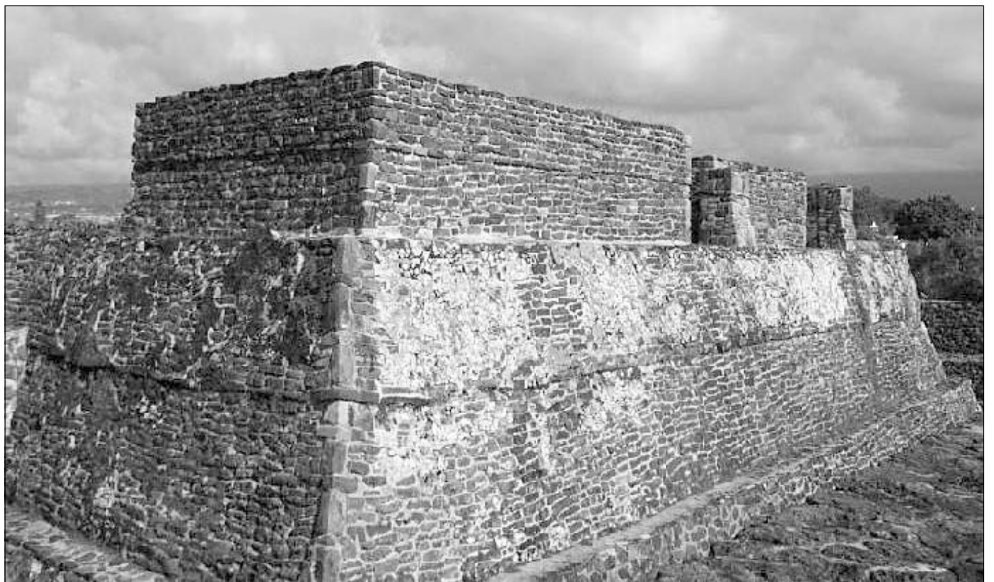
Vista posterior de la subestructura
