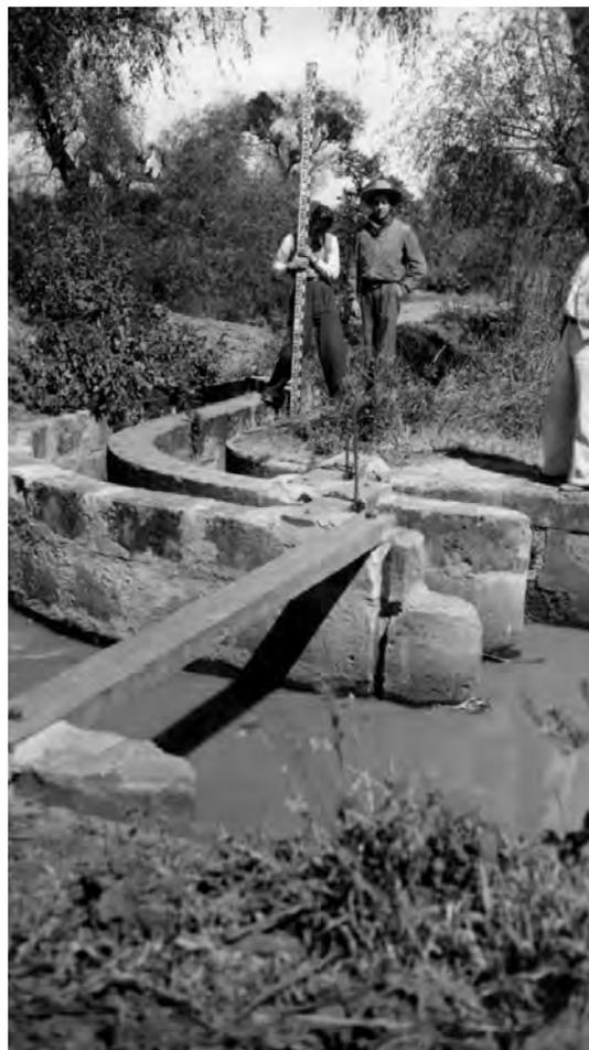
Figura 4. Primer partidor sobre el canal principal, denominado El Molino. A la derecha se ven: la bocatoma del canal de Cincimeo y el canal de El Zapote, y, en el extremo izquierdo, el del Potrero Verde
