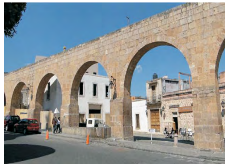
Figura 3. Estacionamiento Villalongín. Intervención final. Carlos Hiriart Pardo, 2011.
