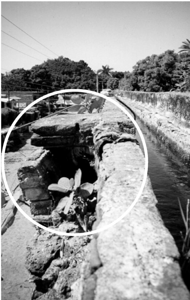
Figura 8. Fotografía que muestra los problemas en el canal del acueducto; se observa que en su momento condujo agua potable. MAC, 2014.
