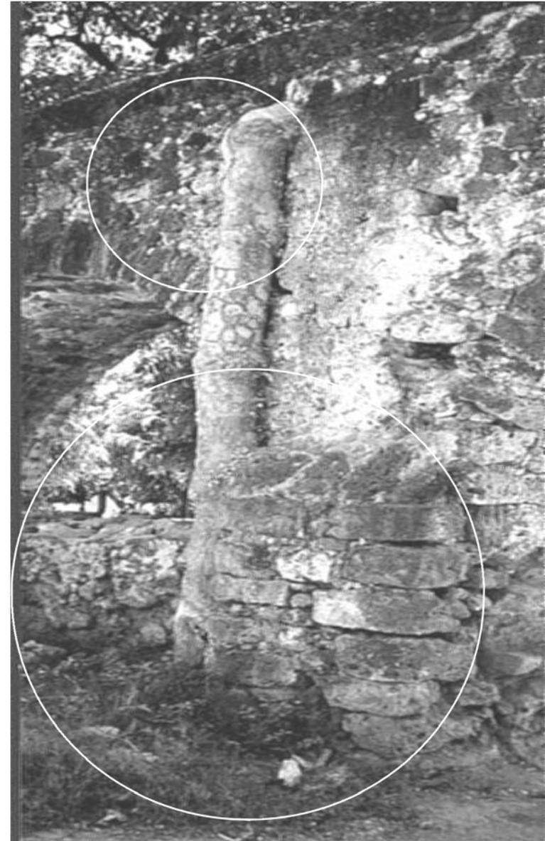
Figura 7. Fotografía que muestra los problemas en la conexión de tuberías en albañal. Alimentación a extensos jardines particulares. MAC, 2009.
