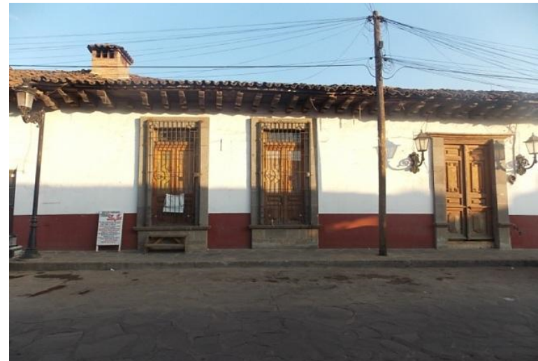
Figura 8. Casona del siglo XIX ubicada en la calle Galeana. Fuente: Foto tomada por la autora.
