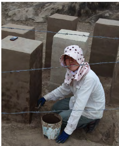
Figura 14. Aplicación del aplanado fino, Annick Daneels, 2013.
