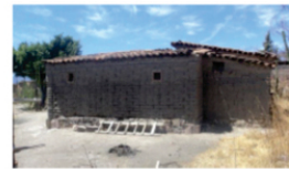
Fachada interior sur del área de cocina desde el patio.
