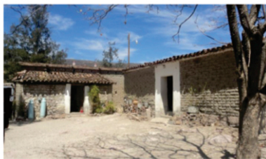
Fachada exterior noreste desde la esquina de la Privada Reforma
