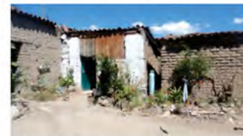
Fachada interior suroeste del exterior de la cocina, desde el patio.
