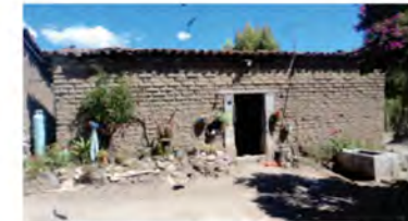
Fachada interior sur del aposento desde el patio.
