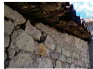
Detalle exterior en cocina, de techumbre de teja sobre una capa de carizo unido con lodo.
