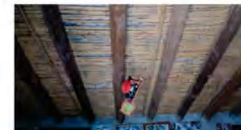
Detalle interior del aposento de viguería de madera y techumbre de teja sobre carrizo unido con lodo
