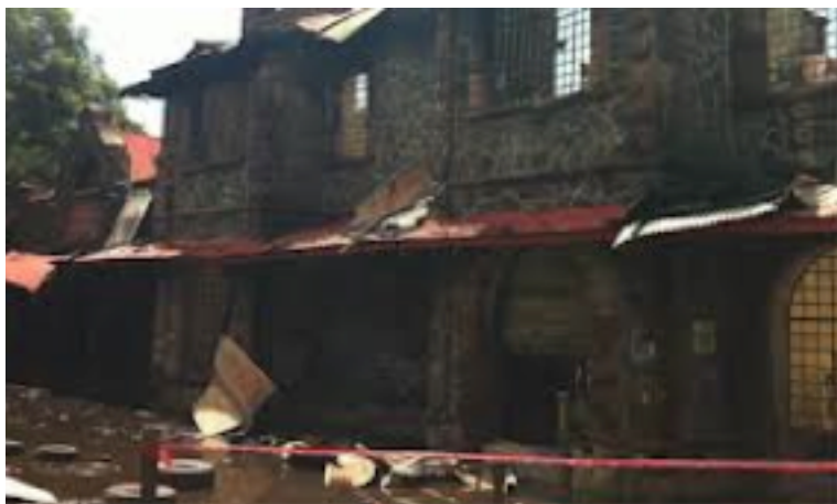
Figura 6. Vista de la fachada principal, 11 de septiembre de 2012.
