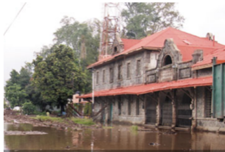
Figura 3. Vista de fachada de los andenes 2011.
