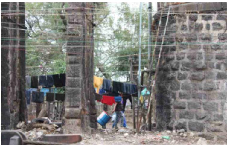
Figura 4. Vista del tanque de agua.
