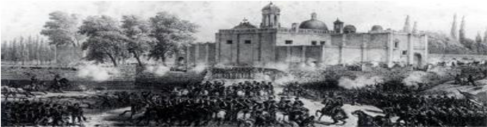
Figura 3. Ex Convento de Churubusco. “La Batalla de Churubusco en el año de 1847”; 1), 2), 3) y 4) imágenes del Ex Convento de Churubusco, exteriores y las áreas de afectaciones analizadas
