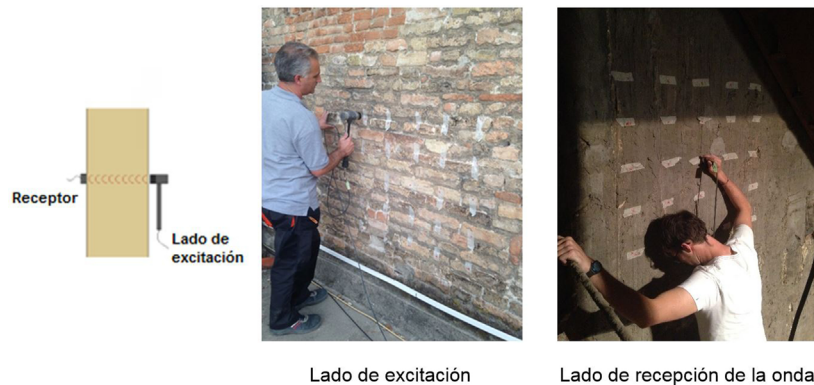
Figura 4. Equipamiento de la prueba de velocidad de pulso sónico.
