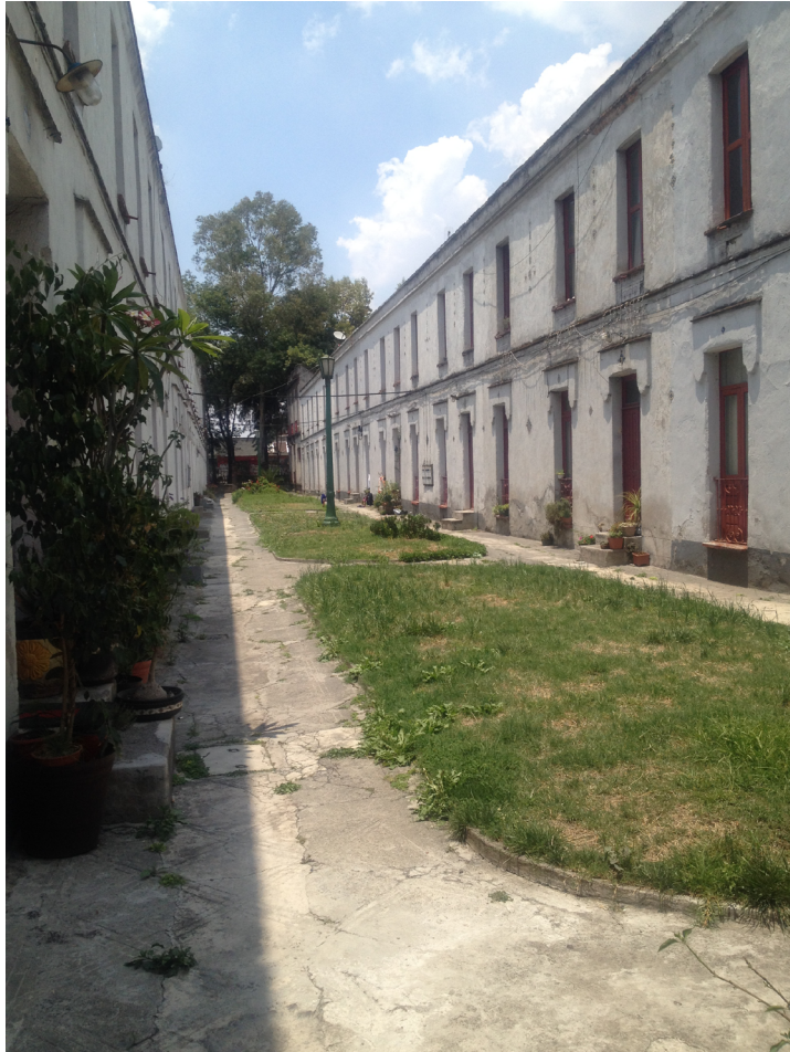
Figura 2. Interior de Privada Alzate 62. Foto: Ángeles Valencia, 2014.
