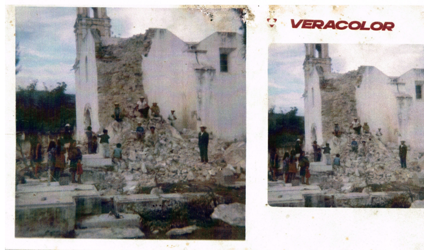
Figura 2. Derrumbe de una de las torres de la iglesia de San Sebastián Villanueva durante el sismo de 1973 (pág. 7).
