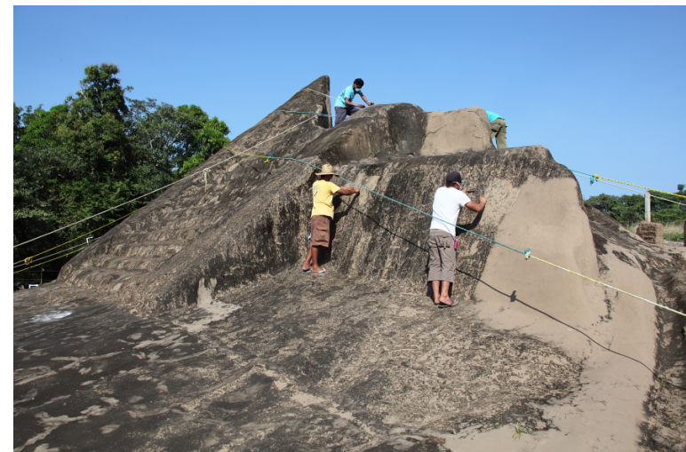
Figura 7. Limpieza mecánica de las algas, Annick Daneels, 2013.
