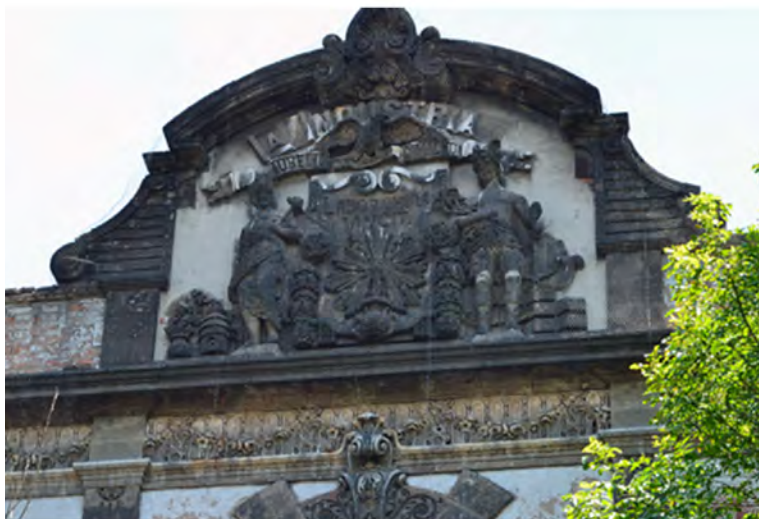
Figura 10. Detalle de la fachada. Foto: Laureana Martínez, 2011.
