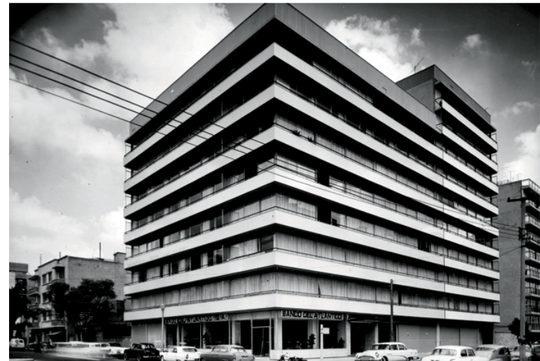
Figura 9. Edificio en Heráclito 331; arriba: “vista elevada desde balcón” y de Emerson 249 y 251, abajo. Dos edificios contiguos que tejen un nuevo perfil urbano con elementos, niveles, proporciones que continúan y reordenan el paramento y crean un perfil urbano mucho más alto, ambos en Polanco, Archivo R. Fierro y Archivo B. Albin.
