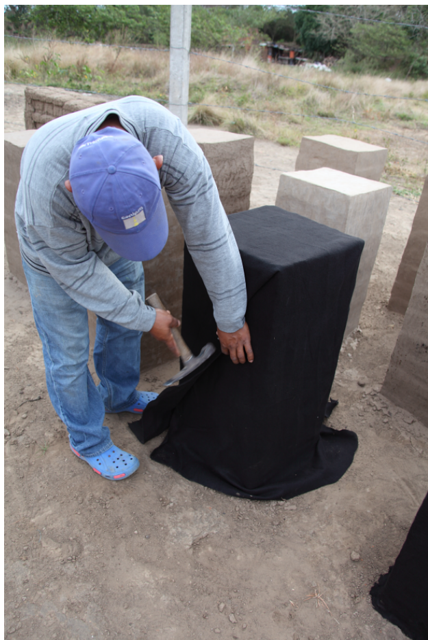
Figura 12. Colocación del geotextil al muro A1g, Yuko Kita, 2014.
