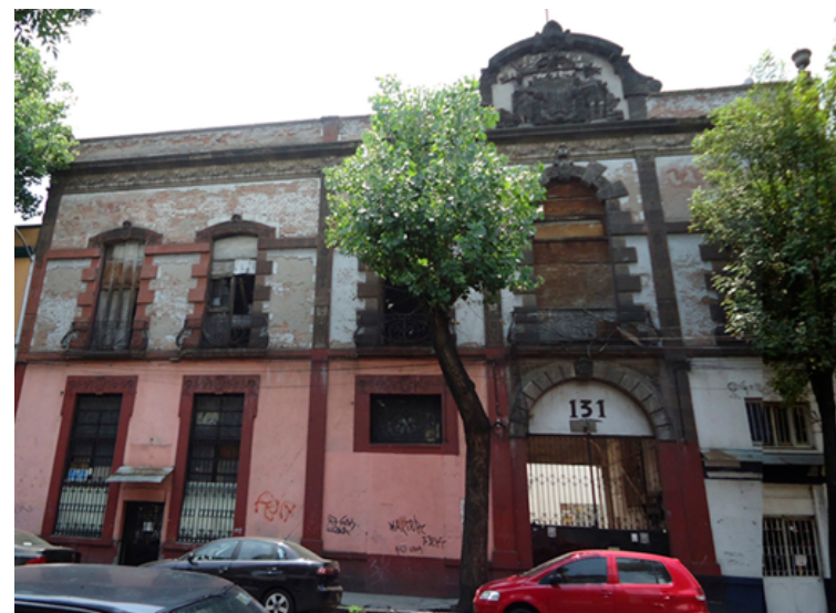
Figura 9. Fachada del edificio ubicado en Fresno 131. Foto: Laureana Martínez, 2012.
