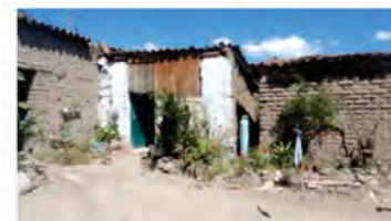
Fachada interior suroeste del exterior de la cocina, desde el patio.
