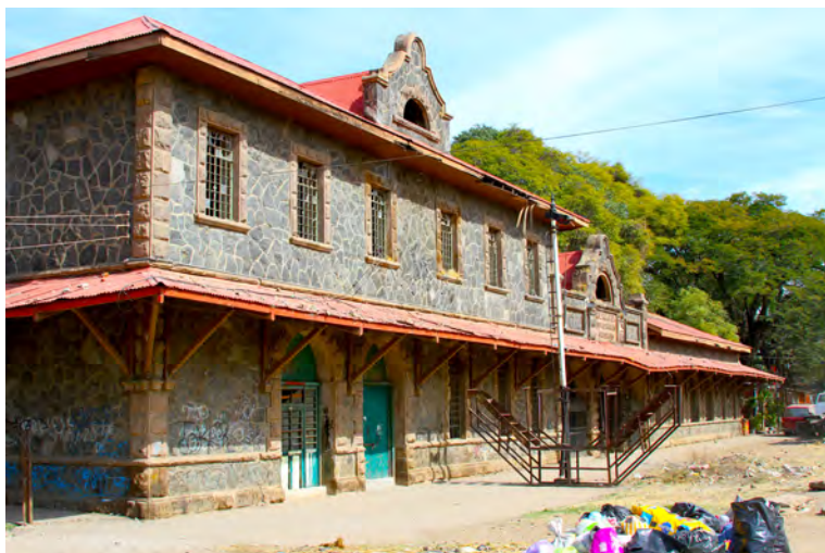
Figura 2. Fachada de andenes.
