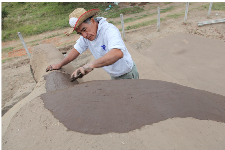
Figura 8. Aplicación del aplanado fino con emulsión asfáltica a la pirámide, Yuko Kita, 2013.
