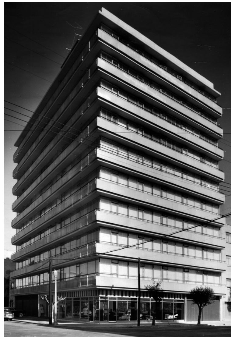
Figura 1. Edificio de apartamentos ubicado en Mexicali 20, col. Condesa, ca. 1957, Archivo B. Albin.
