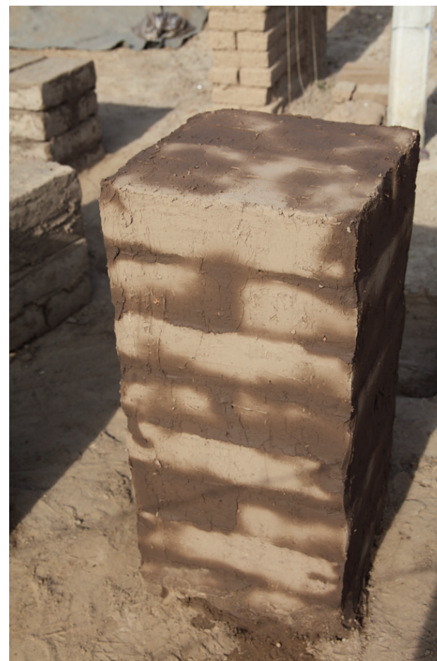
Figura 13. El aplanado base, Yuko Kita, 2013.
