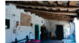
Interior del corredor desde el norte del mismo espacio.
