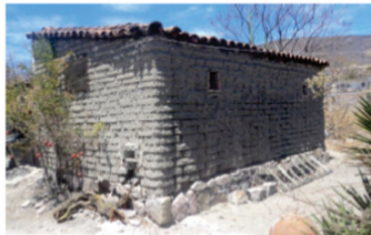
Fachada sureste de la cocina, desde el patio
