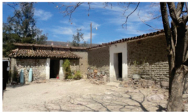
Fachada interior sureste desde el patio
