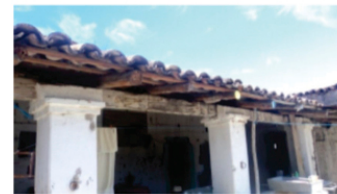
Fachada noroeste del corredor desde el patio.
