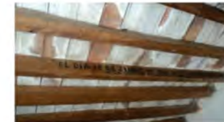
Detalle interior de la cubierta a base de vigas y morillos de madera, tabique mediataba Pegado con arcilla y teja.
