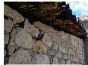
Detalle exterior en cocina, de techumbre de teja sobre una capa de carizo unido con lodo.
