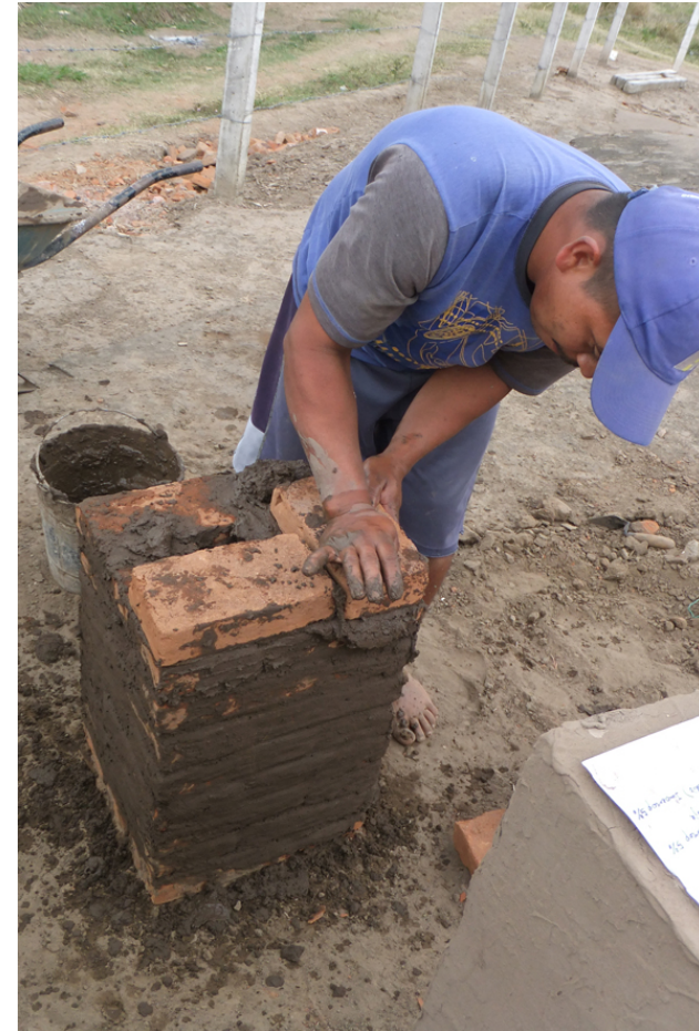
Figura 11. Muro de mampostería de ladrillo, Yuko Kita, 2013.
