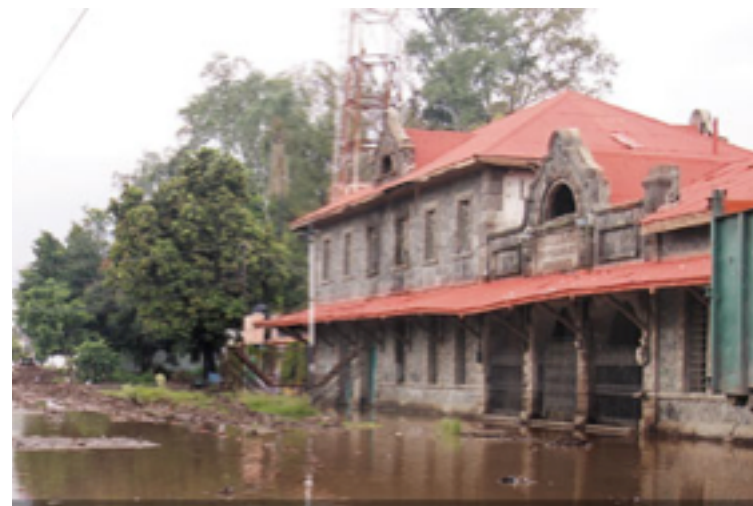
Figura 3. Vista de fachada de los andenes 2011.
