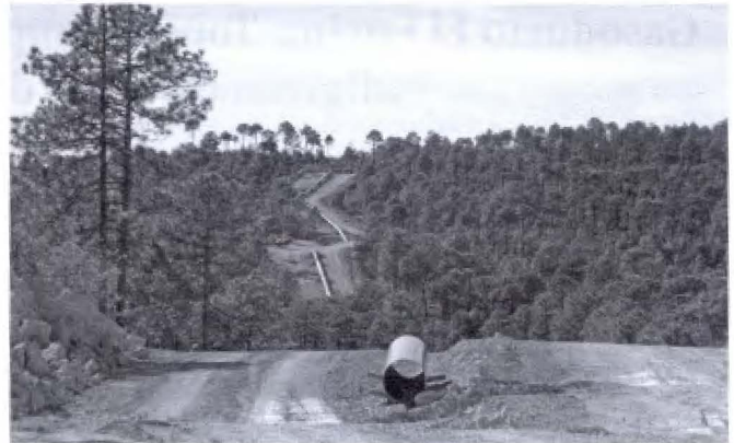
Imagen 20. Instalación de las tuberías. San Elías. Gabriela Fierro. Diciembre de 2014.
