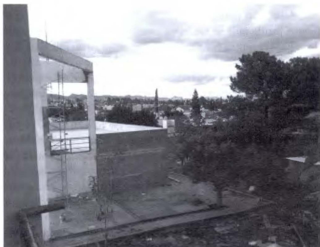
Imagen 1. Construcción del edificio de la EAHNM. Foto Tobías García Vilchis.
