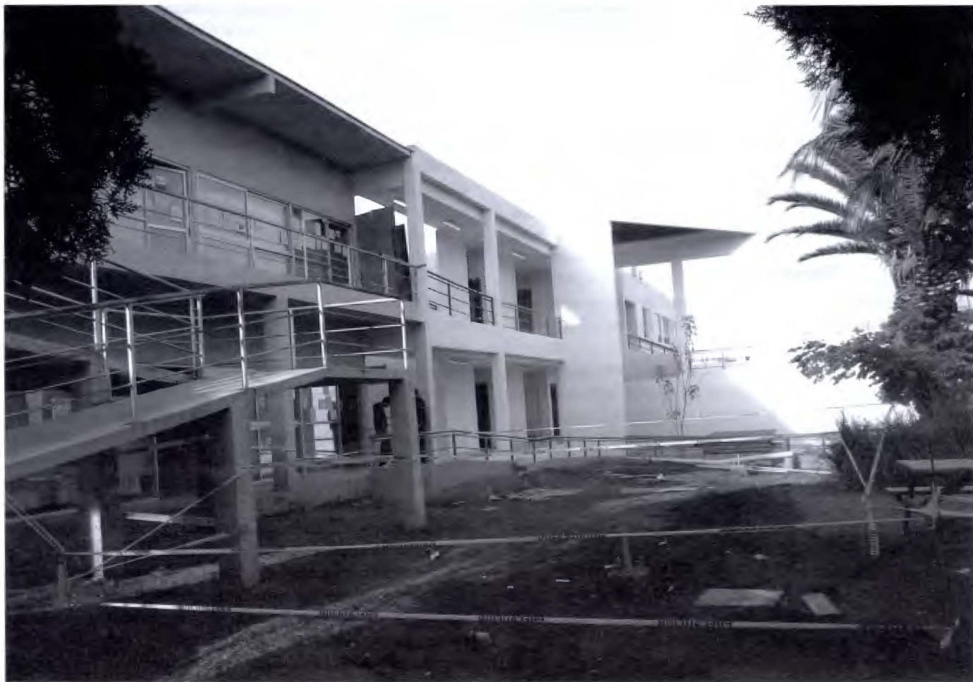
Imagen 16. Obras de Ampliación de la EAHNM . Foto Tobías García Vilchis. Dic 2 2013.
