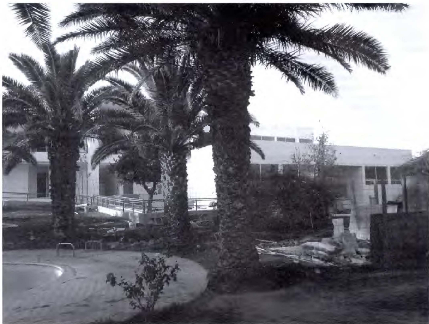
Imagen 2. Construcción del edificio de la EAHNM. Foto Tobías García Vilchis 2013.
