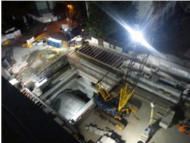
Figura 9. Obras de construcción de la línea 12 del metro sobre la avenida Félix Cuevas, frente al Multifamiliar Alemán. Fotografía del autor, México, septiembre del 2011
