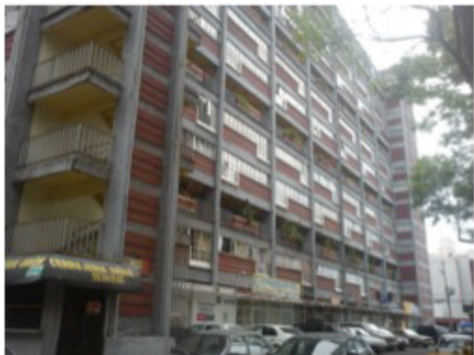
Figura 6. Aspecto actual de la zona comercial del CUPA ubicada sobre la calle Adolfo Prieto; cada comercio tiene un tipo de anuncio diferente del contiguo; el caos visual impera en todas las áreas comerciales del conjunto, lo que demerita su imagen.
