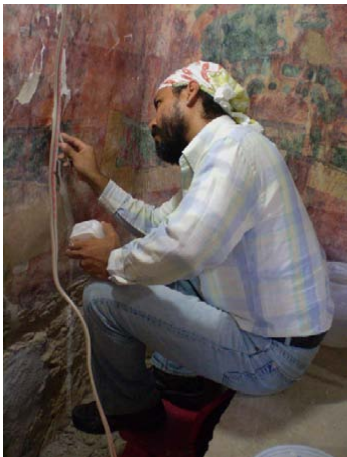
Figura 5. Resane de las grietas que corren a lo largo de los muros divisorios, Edificio 1, Cuarto 3. (Fotografía: Haydé Orea, 2009.)
