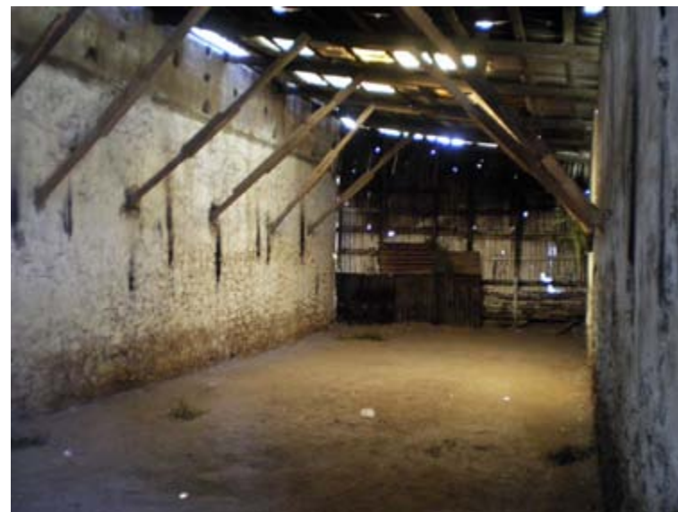
Fig. 4 Adecuación de espacios con elementos discordantes como estructura provisional de madera y cubierta de lámina. Hacienda del Moral Foto: Mónica Márquez. 2010.
