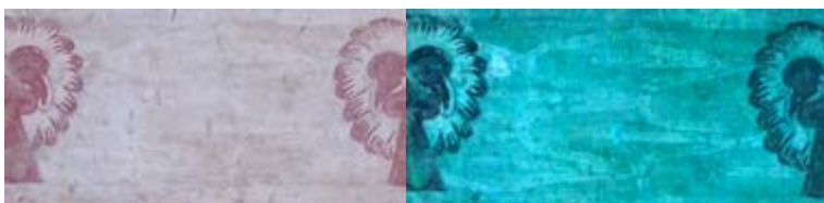
Fig. 6. Gerardo Ruiz Hellión, Detalle del muro norte con luz UV; Ingrid Jiménez Cosme, Detalle con luz natural, fotografía digital, septiembre del 2007
