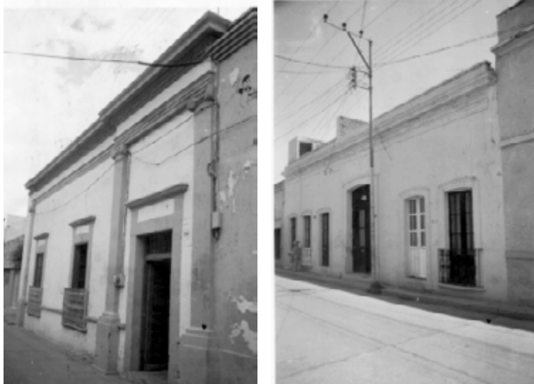
Fig. 1 Izq. Vivienda en calle Leona Vicario, Acámbaro, Gto.
