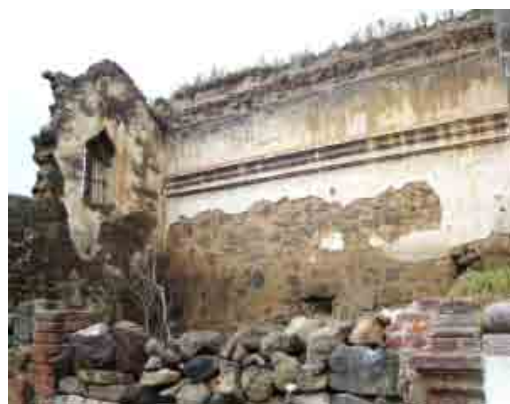
Imagen 12. Vista de la capilla funeraria en ruinas, que se ubica junto al campanario y la cual se planea restaurar para darle uso (fotografía del proyecto).
