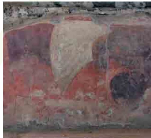
Ilustración 4. Fotografía de inicio de proceso, Muro Norte, tomada por Gerardo Ruiz Hellion.
