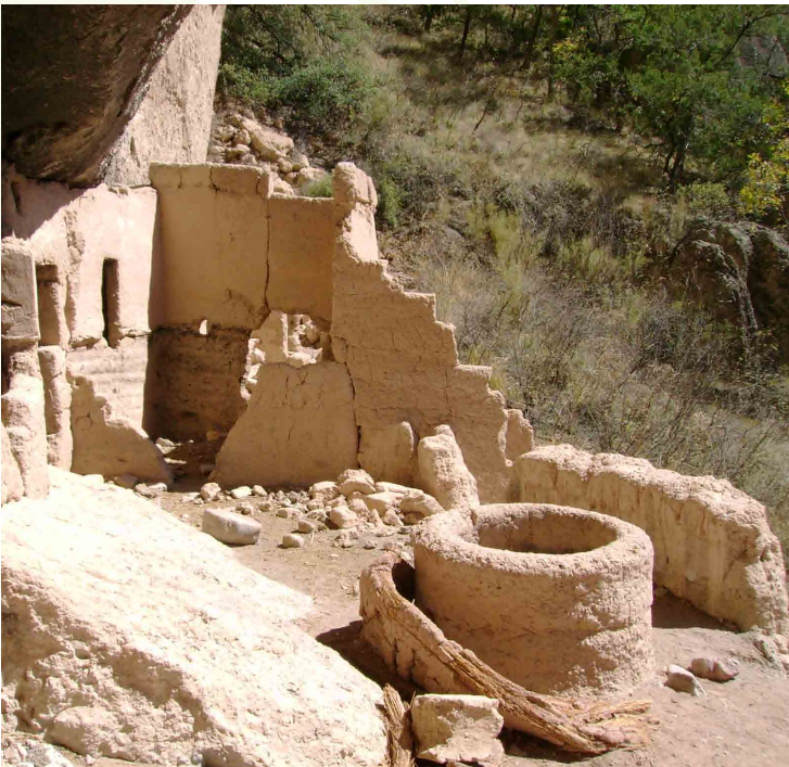
Fig.5. Patrones de deterioro de los muros de la cueva de Sirupa, Chihuahua.
