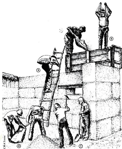
Fig.7. Proceso de elaboración de muros de tapial. Dibujo de CraTerre, [CONESCAL, 1982: 36].
