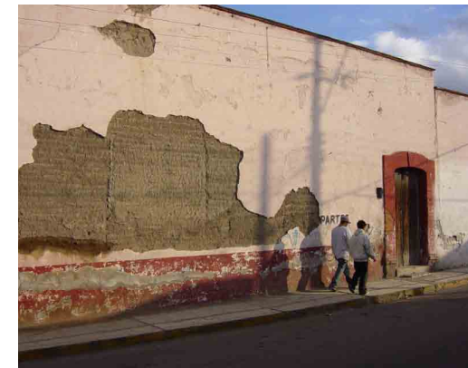
Fig.6. Vivienda de tapial en Calpulalpan, Tlaxcala.
