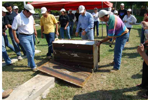
Fig.1. Elaboración de tapiales en un taller organizado por la Universidad de Colima.
