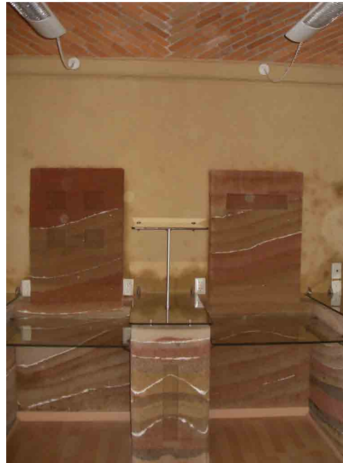
Fig. 8. Integración de tapias en una remodelación contemporánea. Foto Arq. Ramón Aguirre.
