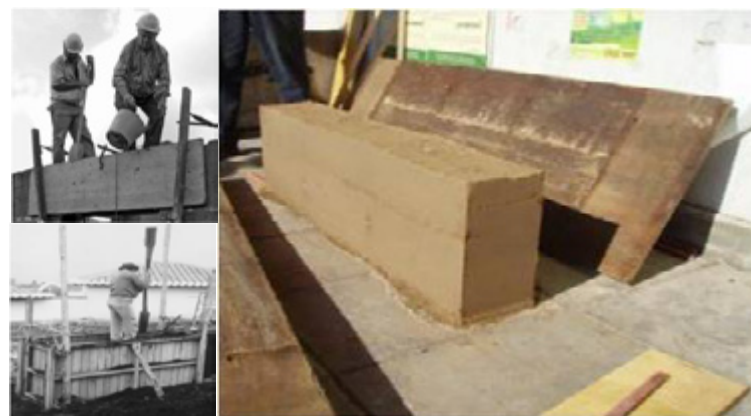
Figura 5. Vaciado, apisonado y desmontaje de cimbra para construcción de muro de tapia. Fuentes: Manual para la rehabilitación de viviendas construidas en adobe y tapia pisada , 1999; Construcción con tierra . Prácticas de extensión en FADU-UBA-Tierra apisonada para muros (Programa Arconti-IAA FADU. Tapial: Arqs. Juan Carlos Patrone y Rodolfo Rotondaro), disponible en < http://contierabaires.blogspot.mx/p/otros-cursos-realizados_13.html >
