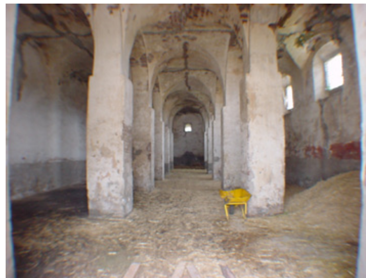
Figura 2. Interior de la troje de la ex hacienda de Queréndaro. Fotografía de la autora
