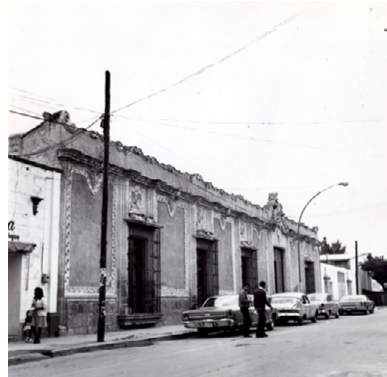
Figura 3. Vista general desde el oriente. Coordinación Nacional de Monumentos- INAH
