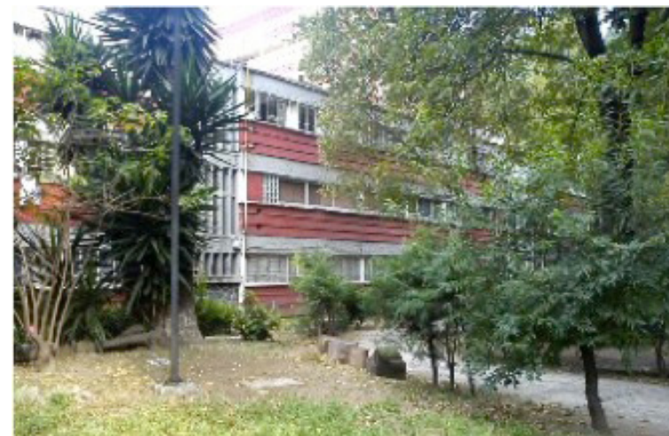
Figura 8. En la actualidad las áreas verdes del CUPA ya no se utilizan para lo que fueron diseñadas sino, lamentablemente, sus habitantes las tienen en estados de descuido y abandono muy marcados. Fotografía del autor, México, diciembre del 2011
