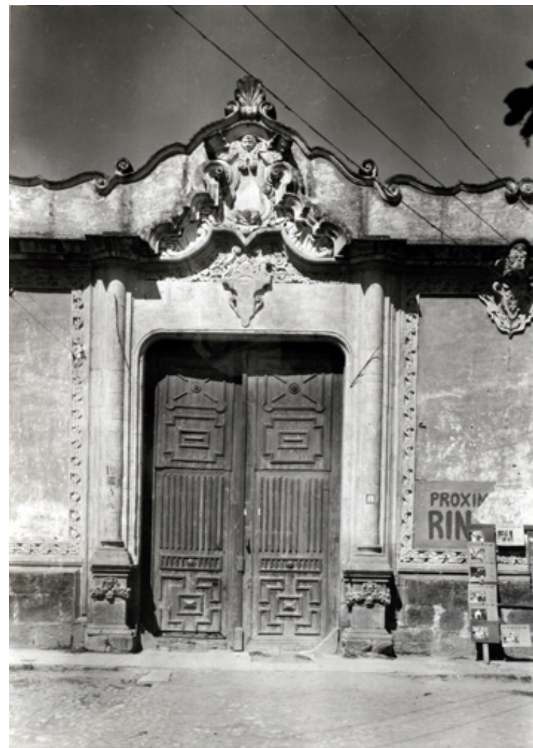
Figura 1. Puerta de acceso. Coordinación Nacional de Monumentos-INAH
